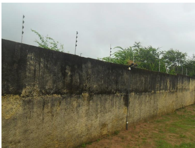
Figura 9 - Imagem de muro
