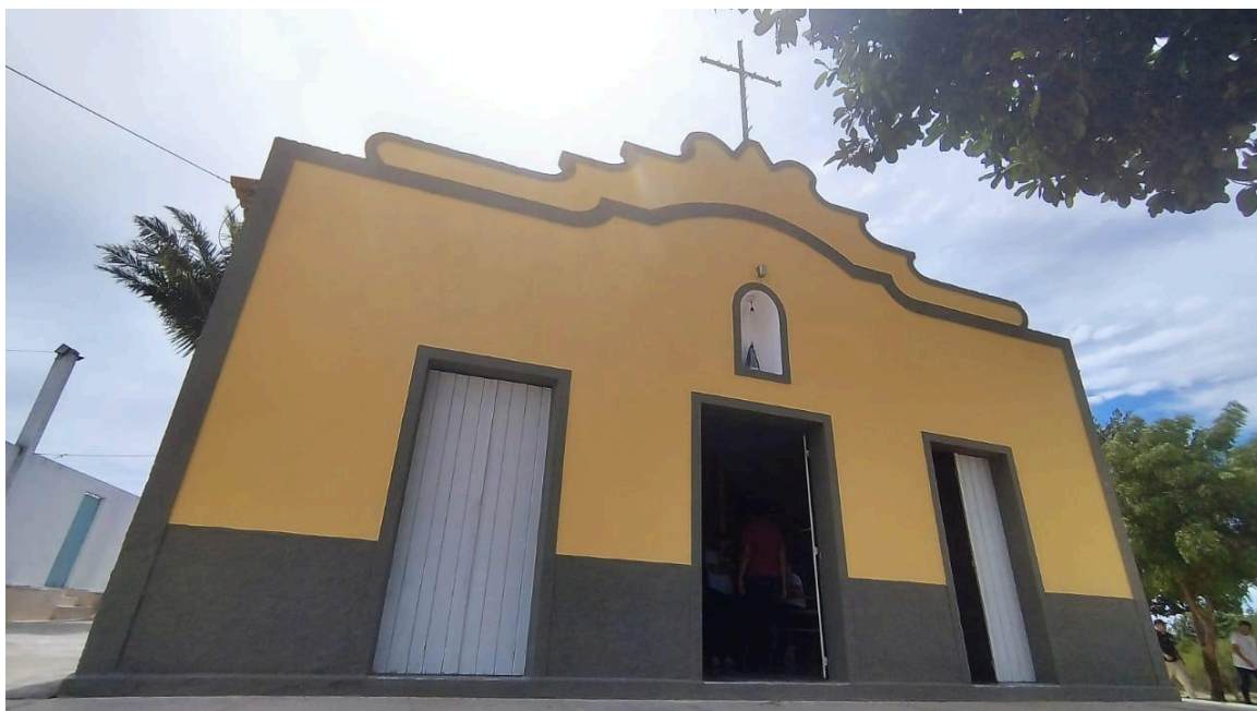
Figura 20. Capela de Nossa Senhora Aparecida
