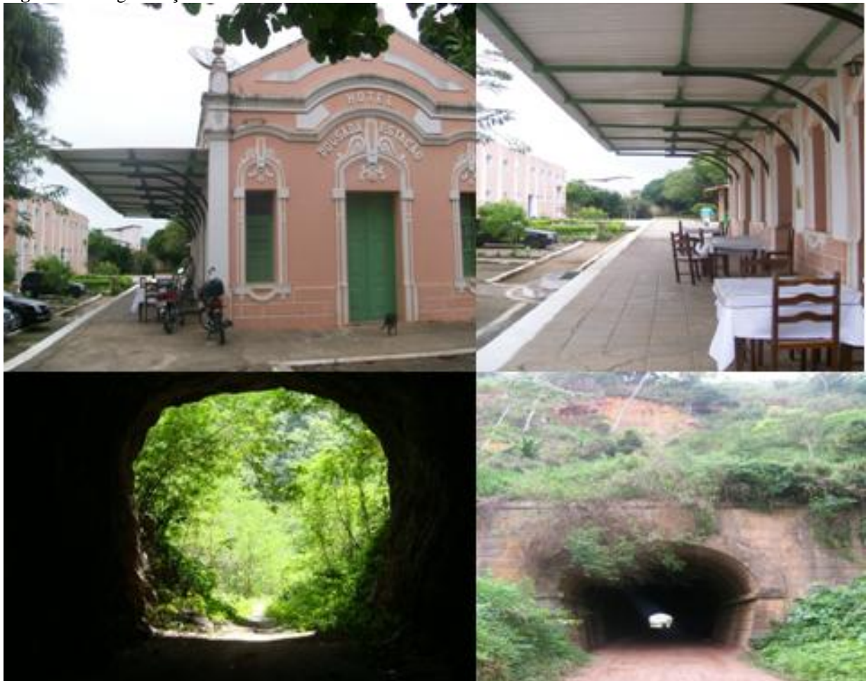
Figura 7: Antiga Estação ferroviária de Bananeiras e Túnel.
