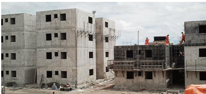
Figura 20 - Construção com parede de concreto moldada in loco.
