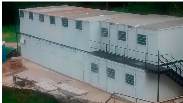
Figura 17 - Uso de contêineres em obra destinados a dormitórios.
