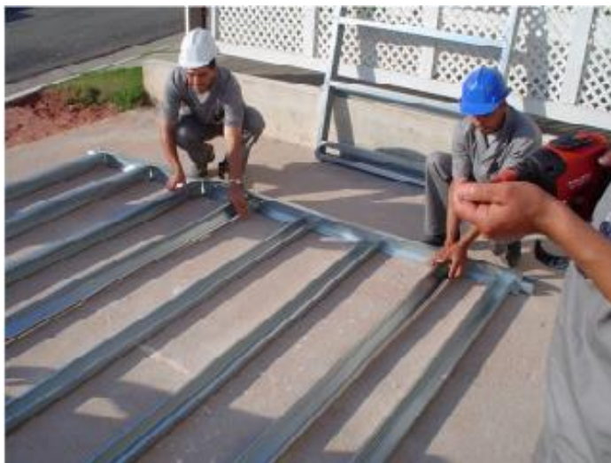
Figura 12 - Uso do Método Stick.
