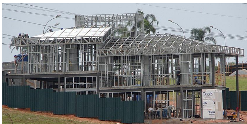
Figura 10 - Construção com Light Steel Frame .
