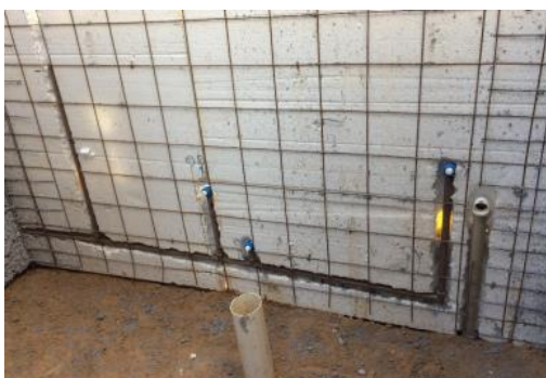
Figura 36 - Instalação de componentes hidrossanitários.
