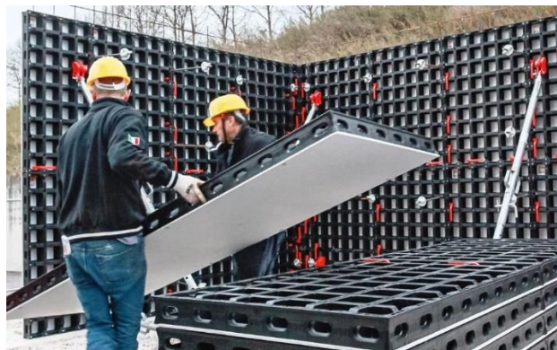
Figura 23 - Formas para paredes de concreto do tipo plástica.
