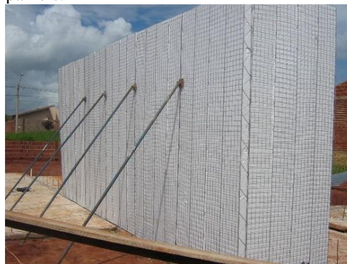
Figura 34 - Escoras para regularização dos painéis.
