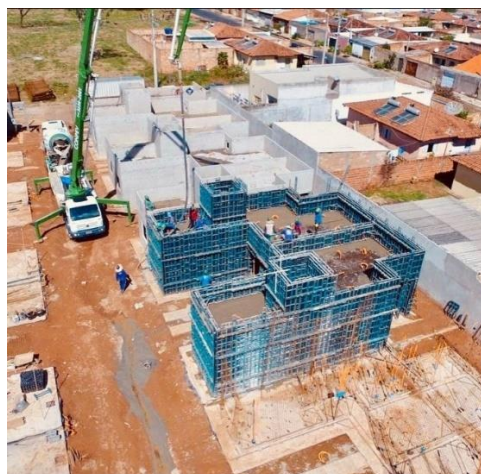
Figura 26 - Concretagem das paredes.
