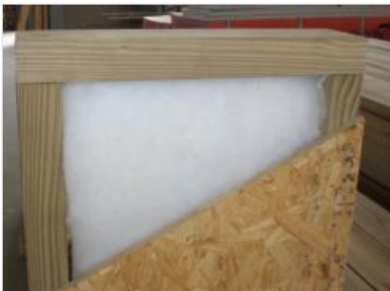
Figura 7 - Isolamento termoacústico com lã de PET.
