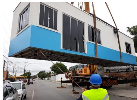
Figura 15 - Transporte de edificação em Steel Frame .
