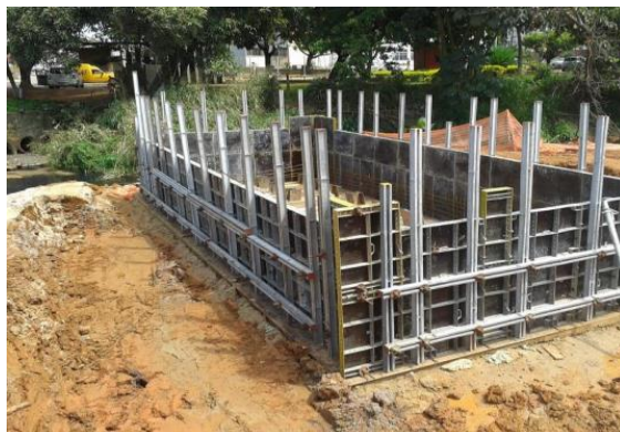
Figura 22 - Forma metálica com chapas de compensado.
