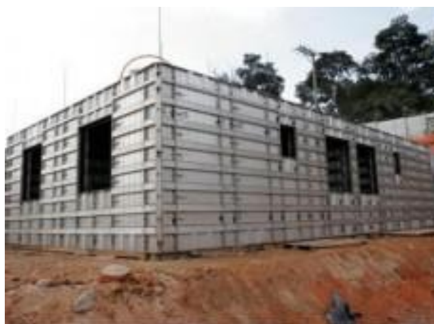
Figura 21 - Montagem das formas metálicas.
