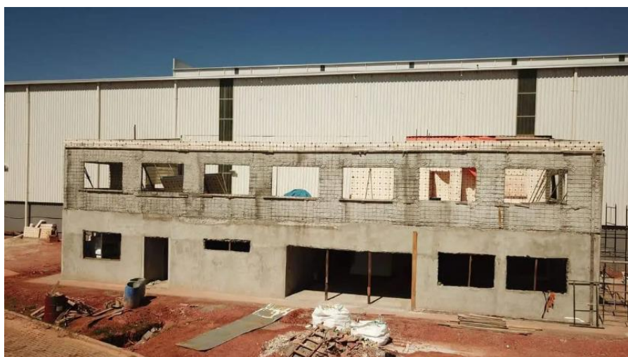
Figura 38 – Execução da etapa de revestimento.
