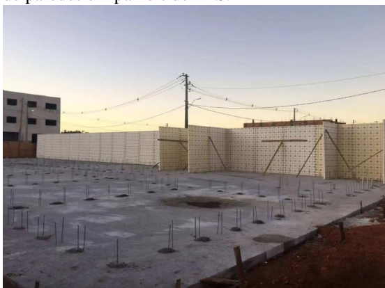
Figura 32 - Fundação do tipo radier para construção de paredes em painéis de EPS.
