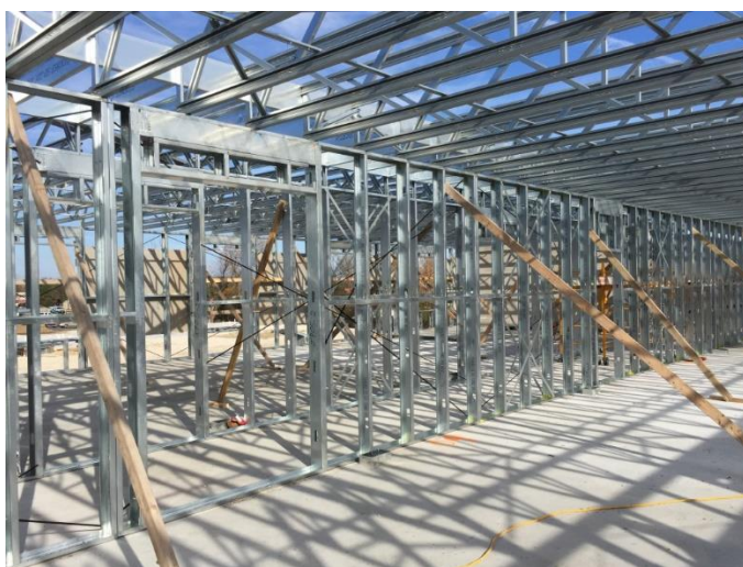
Figura 13 - Uso do método por painéis.
