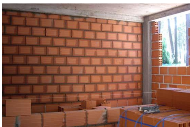
Figura 1 - Alvenaria com blocos cerâmicos.
