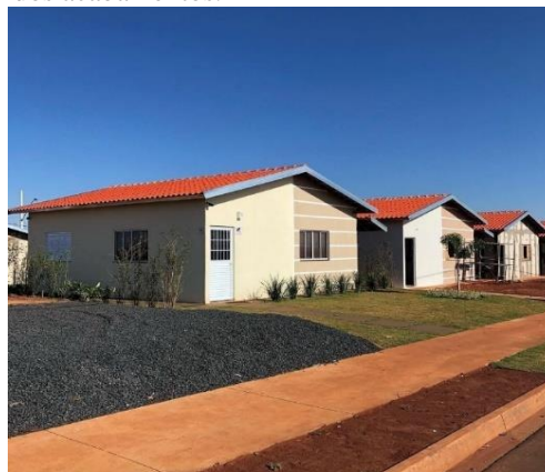
Figura 28 - Edificações após finalização dos acabamentos.
