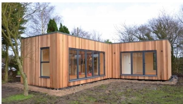
Figura 14 - Casa modular em Steel Frame finalizada.
