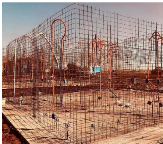
Figura 25 - Montagem da armadura e posicionamento das instalações sobre o radier.
