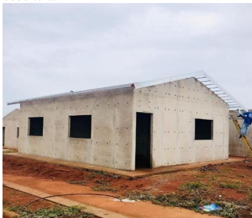
Figura 27 - Desforma e execução da cobertura.
