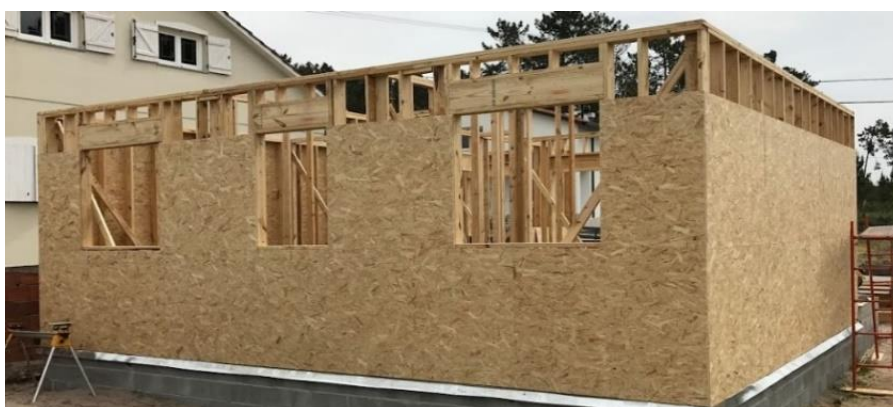
Figura 3 - Construção com Wood Frame .
