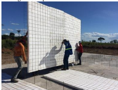
Figura 33 - Instalação dos painéis junto às ancoragens de aço.
