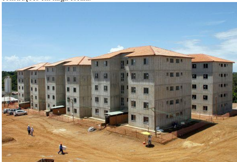
Figura 24 - Utilização das paredes de concreto moldadas in loco em construções em larga escala.
