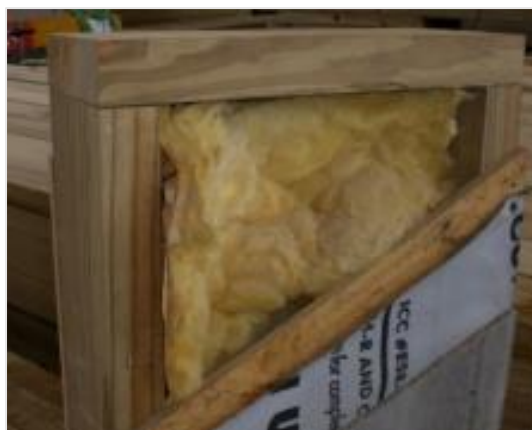
Figura 6 - Isolamento termoacústico com lã de vidro.
