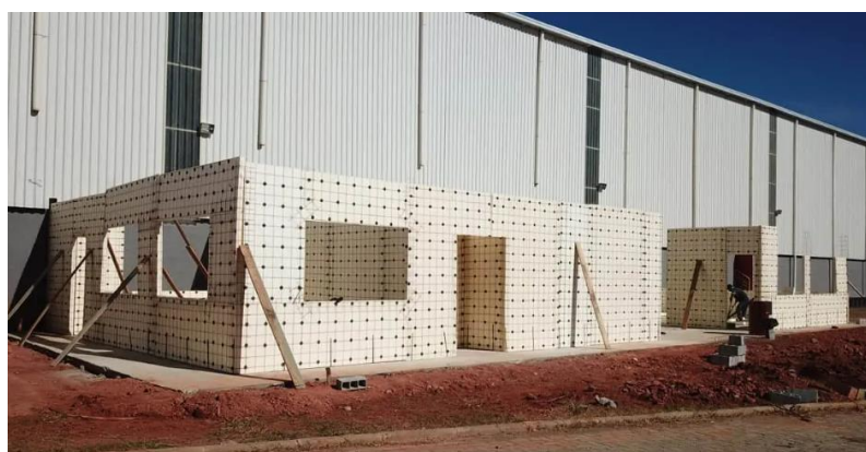
Figura 30 - Montagem dos painéis monolíticos em EPS.
