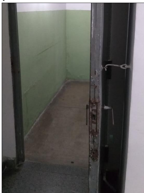
Figura 20 – PCF mantida aberta no pavimento térreo.
