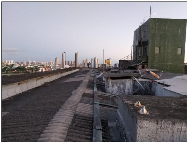
Figura 21 – Cobertura do prédio.
