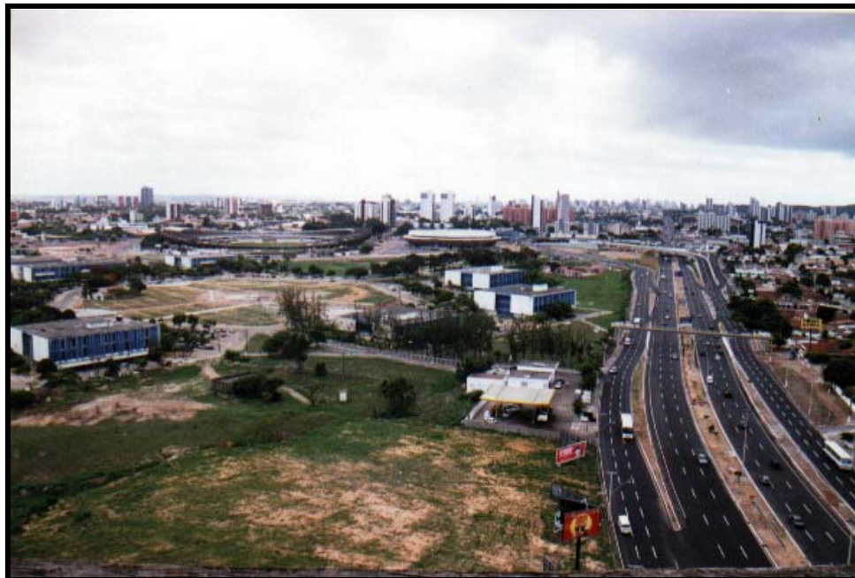
Figura 4.9 – Vista panorâmica do Centro Administrativo do Governo estadual, mostrando a descaracterização da lagoa Nova – mar/2000.
