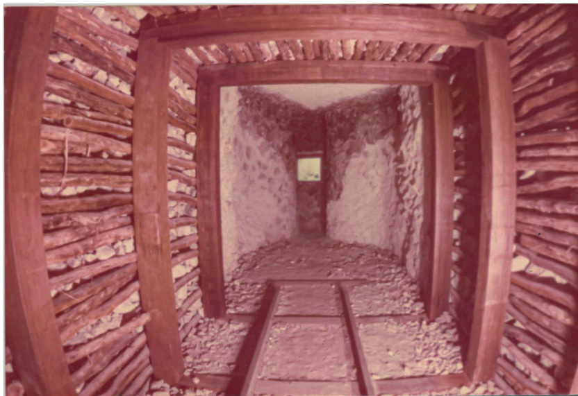
Figura 14. Reconstituição em madeira, cimento e pedra de túnel de mineração da empresa Mineração Thomas Salustino. Fonte: Acervo de Fotografias do MCC/UFRN.
