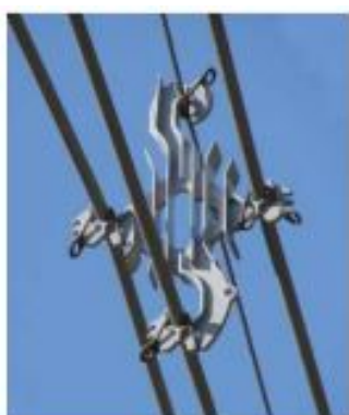
Figura 3 – Espaçador losangular para Rede Compacta (Spacer).
