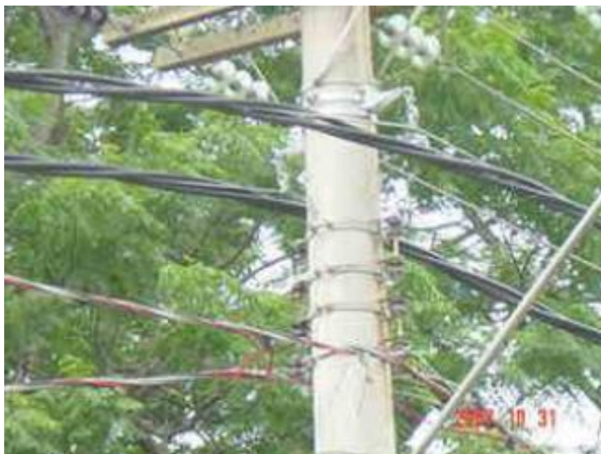
Figura 4 – Rede multiplexada de Média Tensão.
