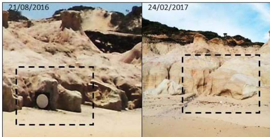
Figura 4.15 – Vista de trecho do setor 01 durante os dois levantamentos de campo. Na área em destaque é evidenciado na faixa de praia sinais de constantes fluxos pluviais.
