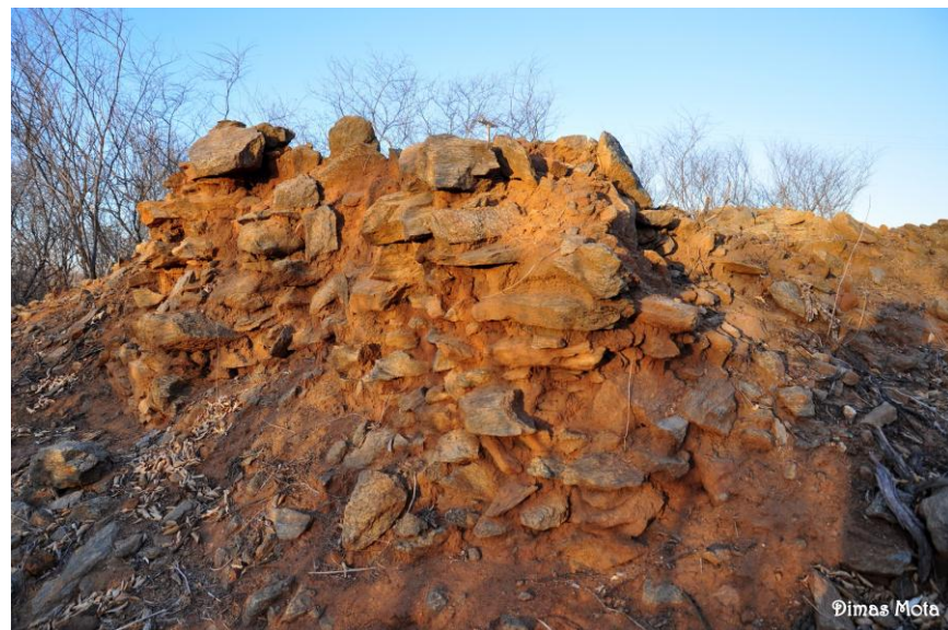
Figura 4 – Parede vizinha à capela
