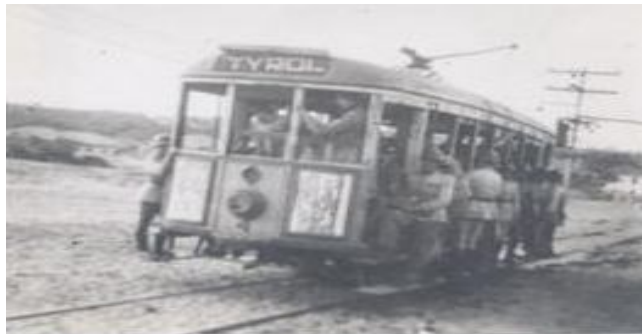
FOTO 02 – Bonde da linha Tirol (trecho não identificado) durante a II Guerra Mundial: vagaroso, trafegando por uma região do bairro com poucas edificações e ausência de pavimentação. Presença de muitos militares utilizando o veículo. Acervo: Altman.
