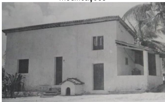
Figura 32: Exemplo de edificação após modificações
