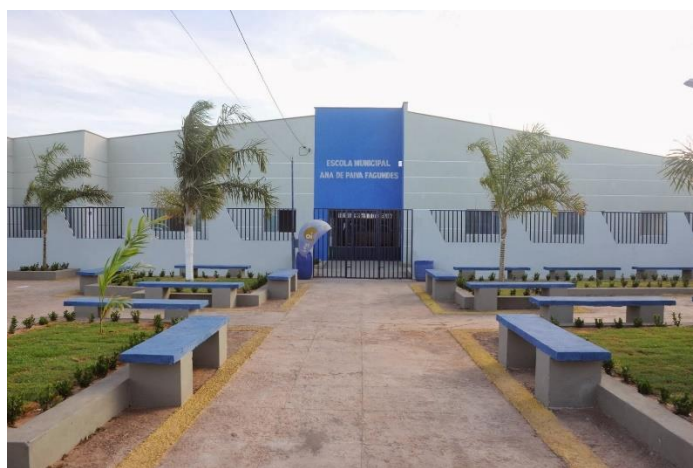
Figura 56: Escola Municipal em Punaú
