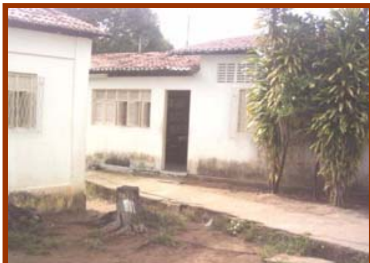
Imagem 03 – Espaço lateral da escola – Araújo, A.. C.
