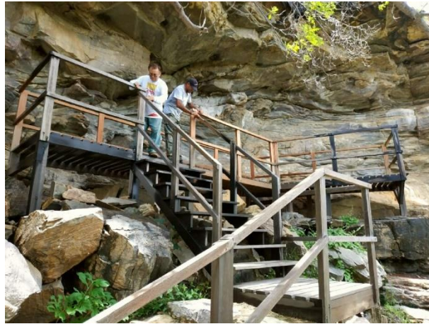
Figura 8 – Lixamento na passarela de madeira do geossítio Xiquexique.
