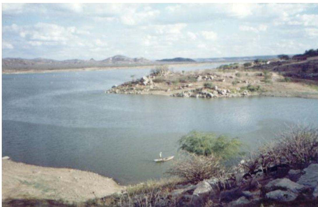
Figura 37: Barragem Boqueirão – aspecto geral
