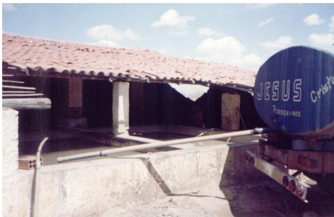
Figura 17: Chegada da água na Cerâmica
