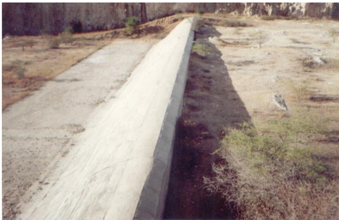
Figura 39: Barragem Boqueirão – sangradouro
