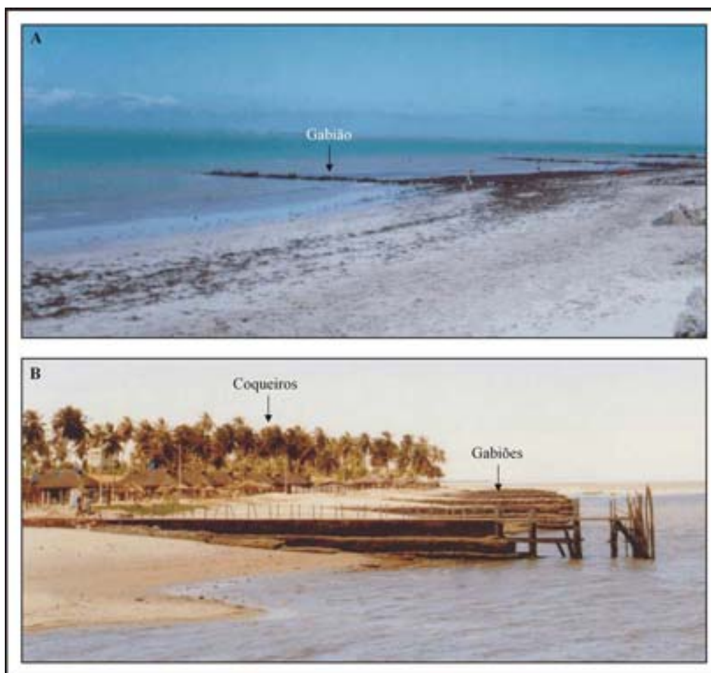
Figura 3.16 – Construção de gabiões como medida de contenção da erosão costeira. Foto A – costa de Cabedelo e Foto B – costa de Lucena.
