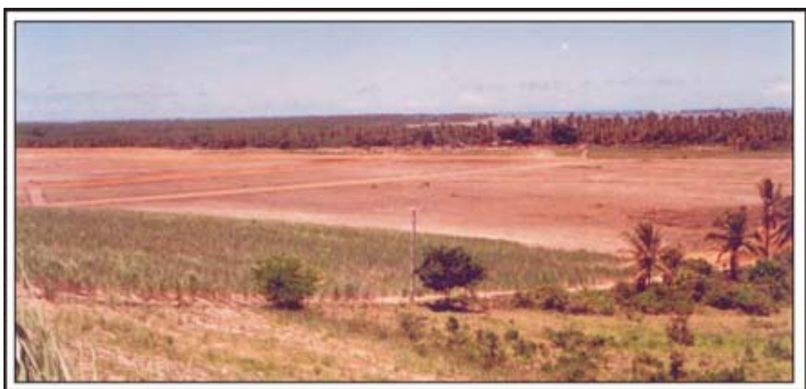
Figura 3.12 - Viveiro de camarão em construção, evidenciando o crescimento da atividade de carcinicultura no ERPN.
