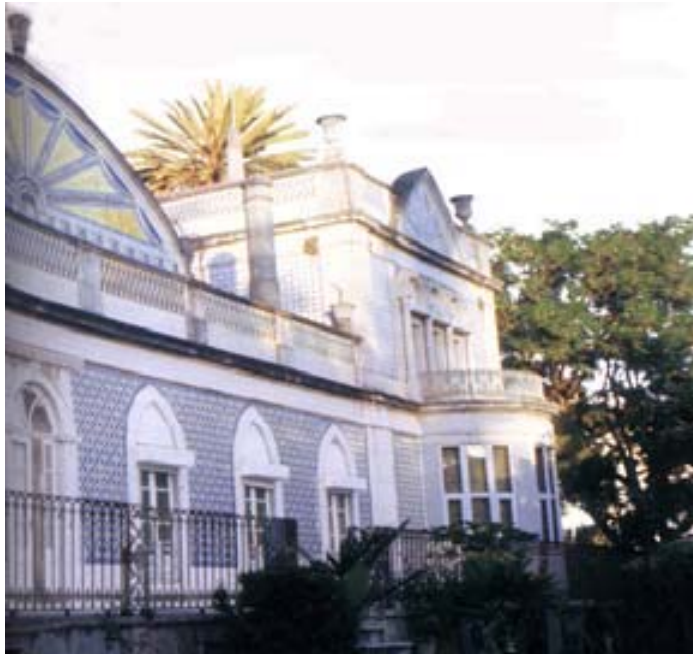
Figura 2.1- Utilização de placas cerâmicas de revestimento na parede ( Quinta de Beau Sejour Benfica-Portugal )
