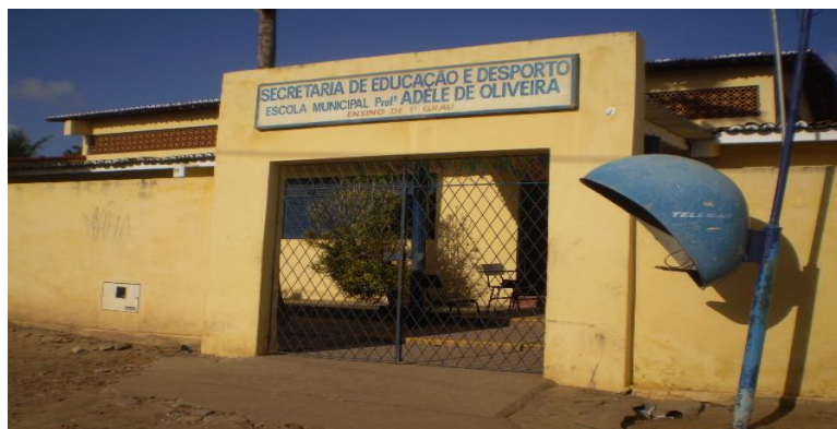
Figura 2 Fachada da Escola Municipal Adele de Oliveira.
