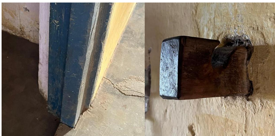
Figura 2-5- Utilização de elementos de madeira na arquitetura vernacular do semiárido: (a) marco de porta (b) armador de rede
