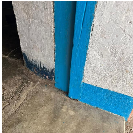
Figura 4-23- Parede externa: Fazenda Ingá
