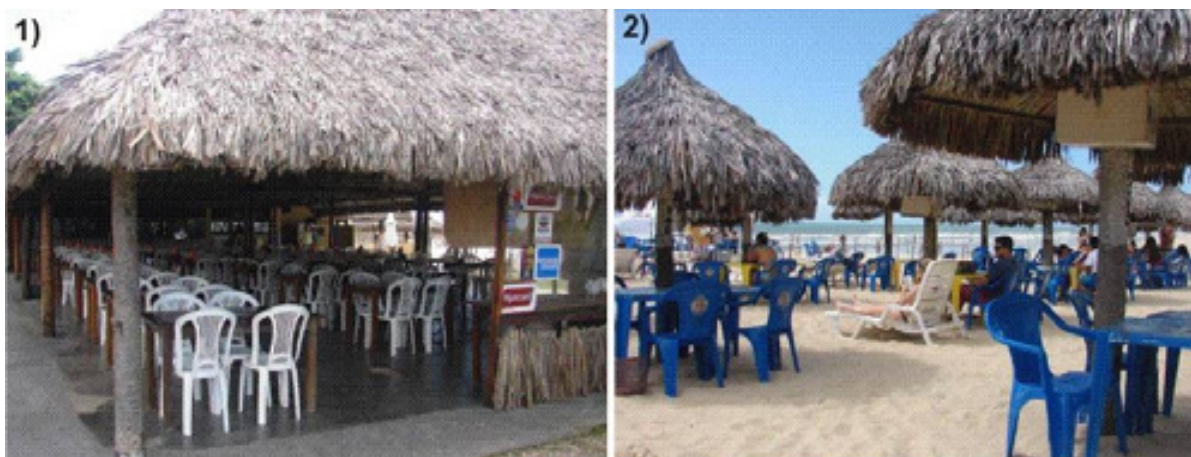
Figura 37: Imagens da barraca Vira Verão: 1) Área de mesas da estrutura principal; 2) Quiosques fixos na faixa de praia. Fonte: Arquivo pessoal, julho de 2009.
