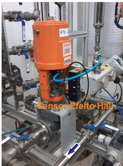
Figura 6.5: Conjunto válvula de controle, posicionador e sensor HALL.
