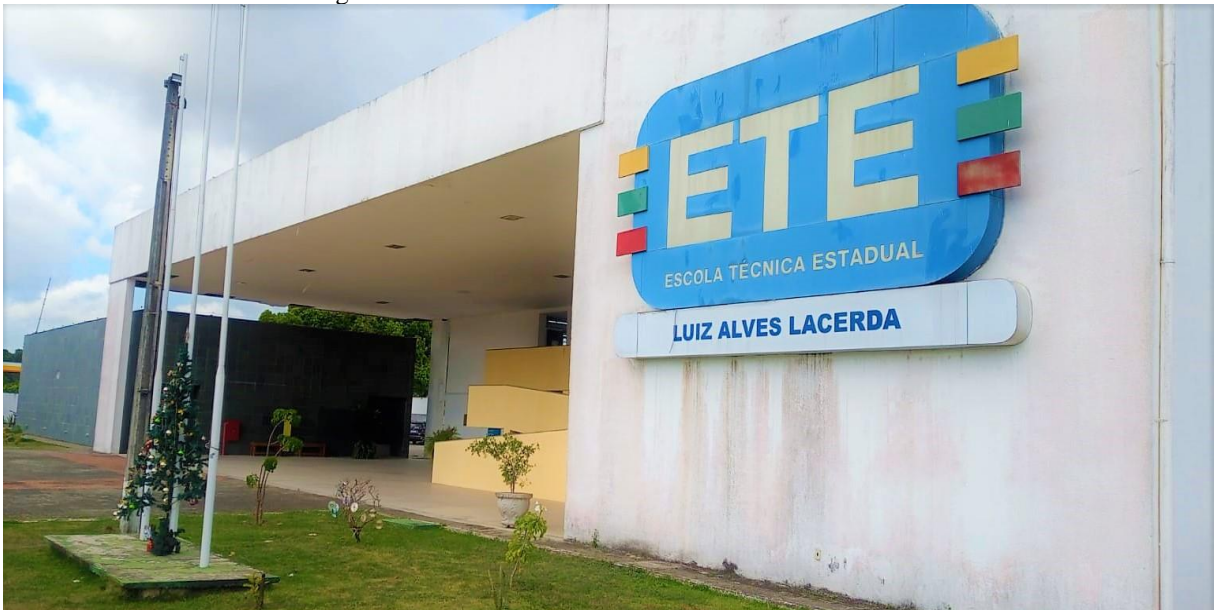
Figura 1 – Fachada da ETE Luiz Alves Lacerda
