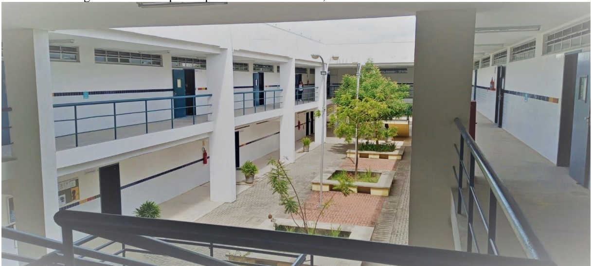
Figura 2 – Hall principal: Salas de Aulas, Laboratórios e Administrativo.
