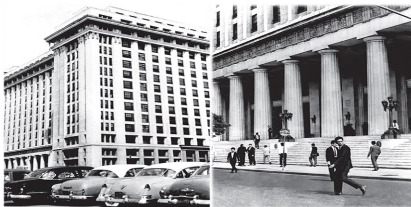
Figura 8 Sede do antigo Ministério da Fazenda, localizado na região do Castelo, centro do Rio Fonte: CAVALCANTI, 2006.
