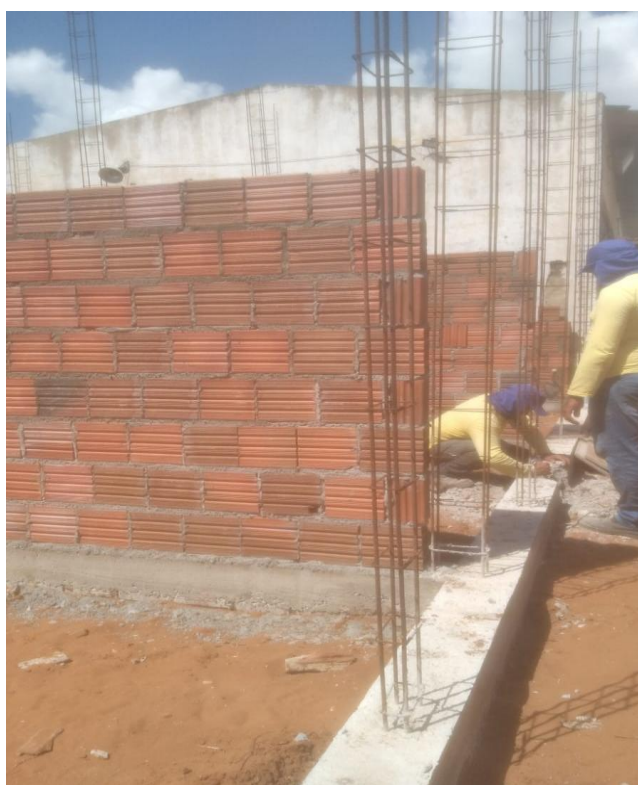
Figura 100 – Construção de novo pavilhão e novas celas na UPCT. Policial Penal, 2023.
