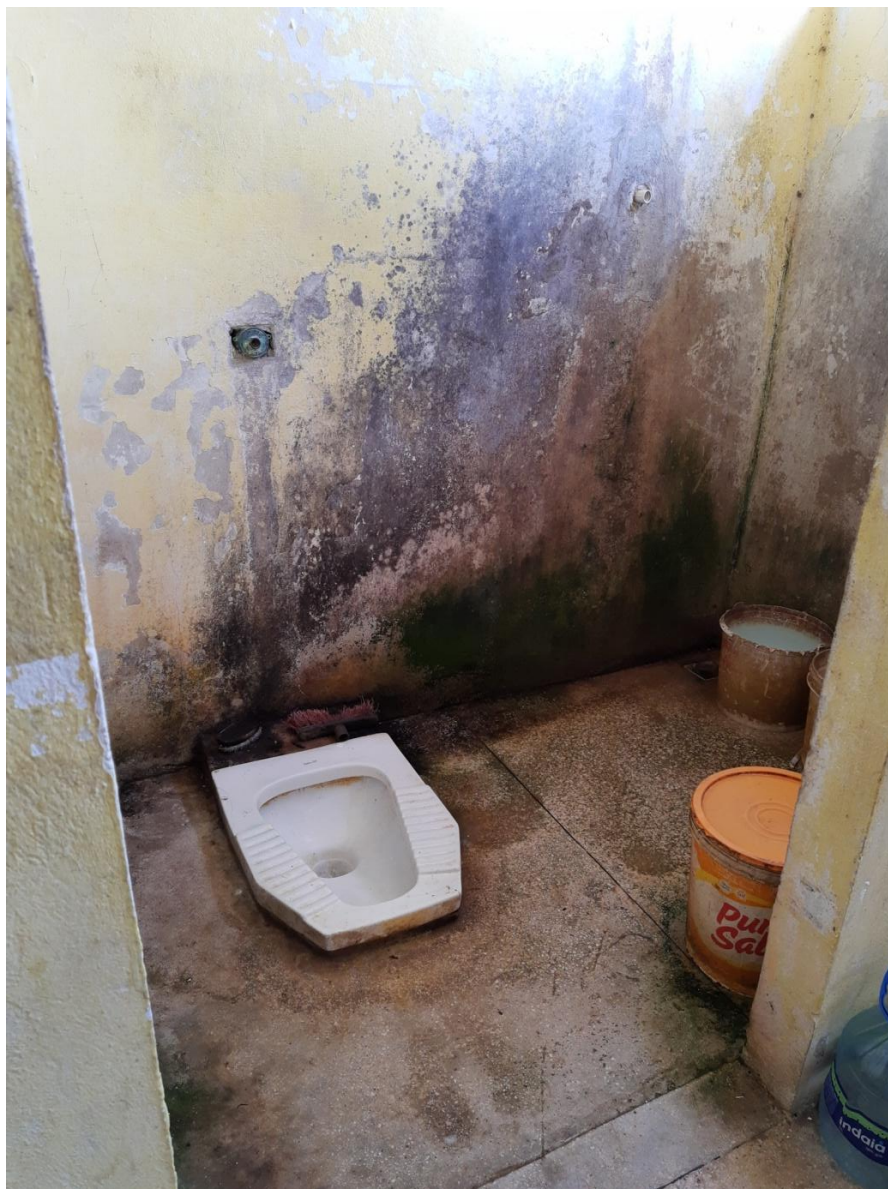
Figura 10 – Banheiro em cela da UPCT. Acervo pessoal, 2019.
