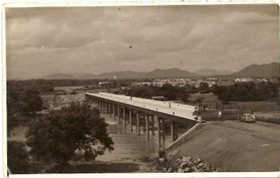
Figura 7: Construção da ponte sobre o Rio Piranhas, São Bento - PB
