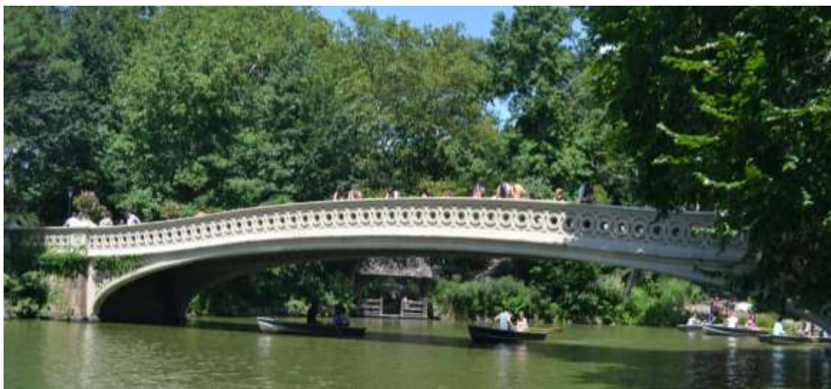
Figura 6.5– As pontes Bow (acima), Gothic (centro) e Bank Rock (abaixo).
