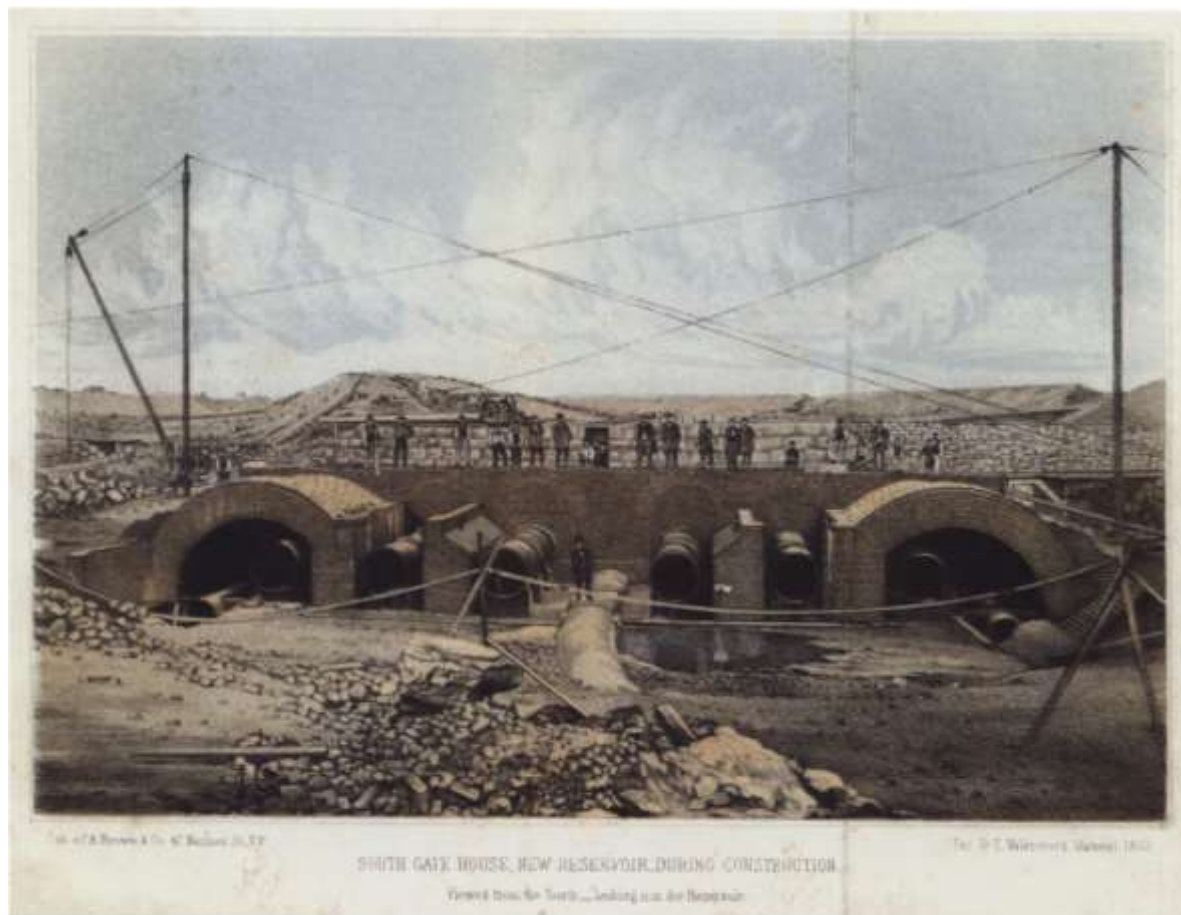
Figura 6.30 – Portão Sul, Reservatório Novo sendo construído, 1862. Vista no sentido sul-norte.
