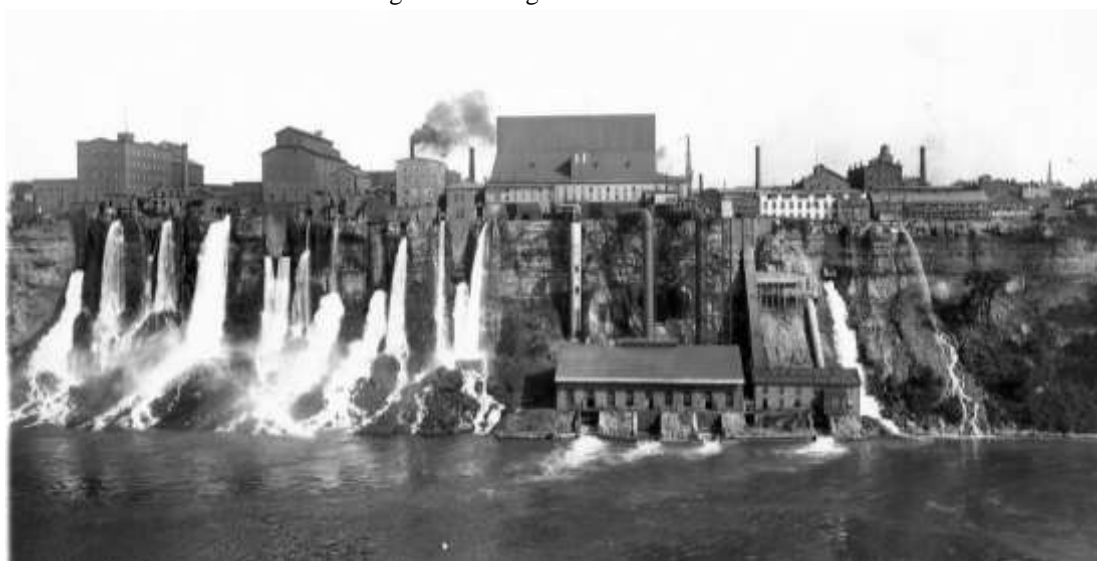
Figura 4.6- Distrito dos Moinhos na Garganta do Niágara.
