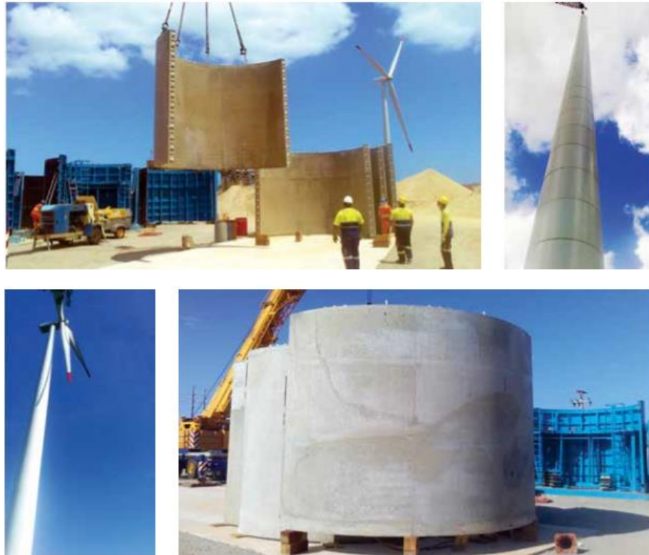
Figura 5 Processo de fabricação de torres pré-moldadas e torre montada
