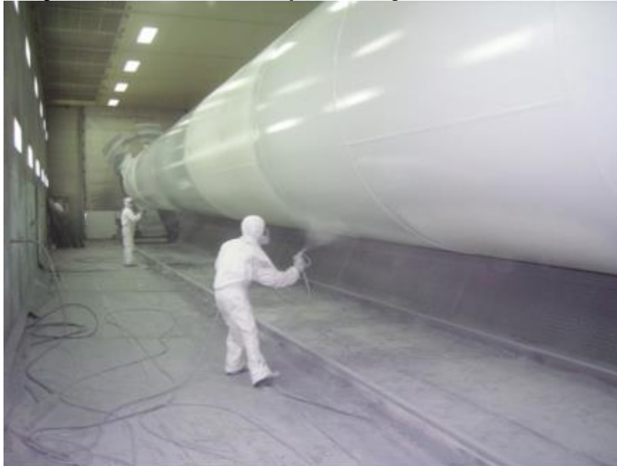
Figura 4 Pintura de Torre tubular de Aço soldadas longitudinalmente e transversalmente
