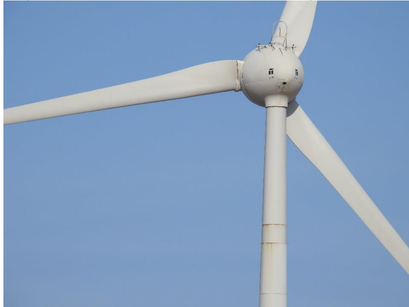
Figura 9 Torre de concreto em boas condições. Corrosão no segmento metálico
