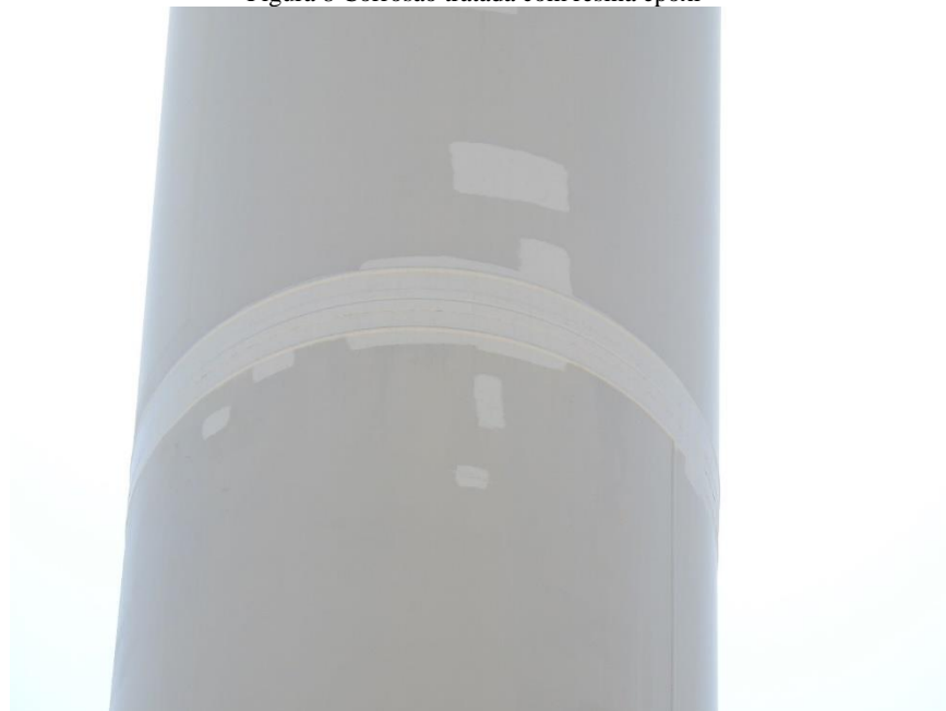
Figura 8 Corrosão tratada com resina epoxi
