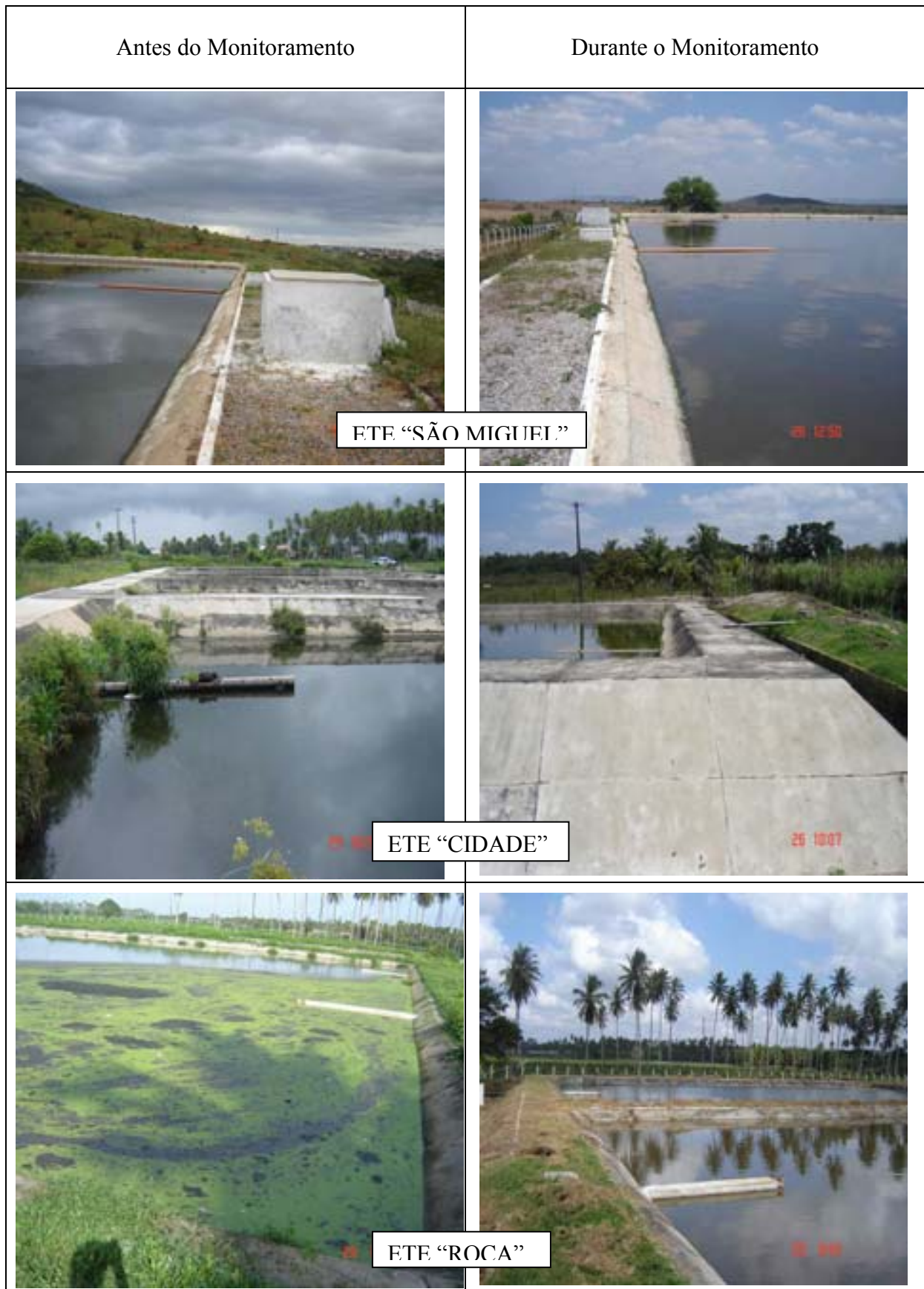
Figura 45 – Aspectos dos sistemas antes e durante o monitoramento.
