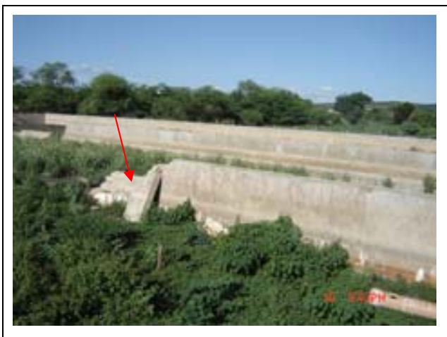
Figura 09 – Detalhes de procedimento de construção deficitário e carregamento errado.
