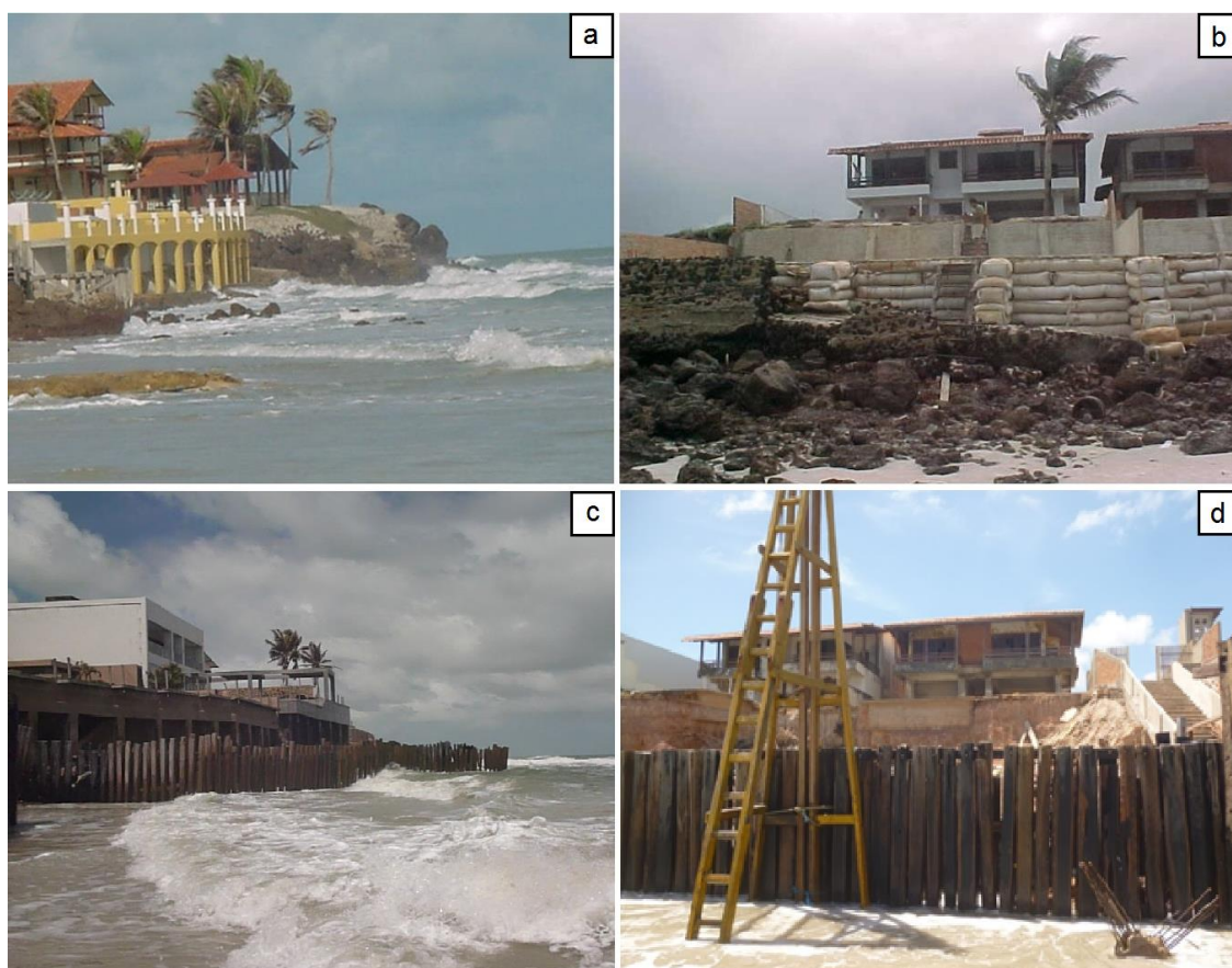
Figura 5.44: Obras de contenção à erosão na praia do Atalaia/PA em 2004 (a e b) e em 2014 (c e d). Fotos (a) e (c) e (b) e (d) dos mesmos pontos de observação. Fonte: (a) e (b) MPEG e (c) e (d) LAIT e GEOPRO.
