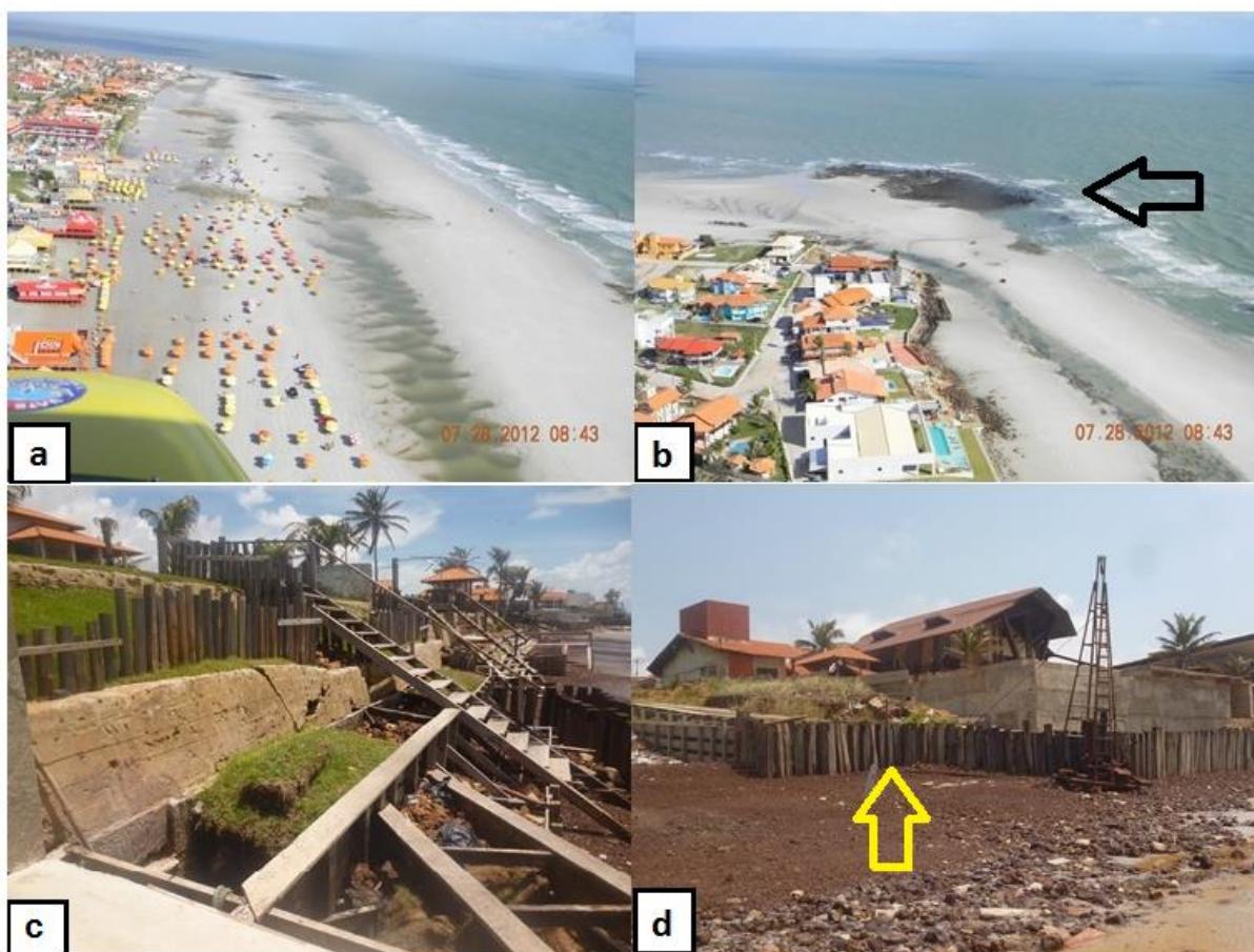
Figura 3.2: Vista aérea da Praia do Atalaia durante a baixa-mar (abril 2012) (a) do setor comercial (restaurantes-palafita e barracas na praia), (b) das segunda-residências e do afloramento de rochas calcáreas da formação Pirabas (seta preta), (c) muro vertical e gabião em madeira preenchido com pedra (d) estaqueamento de madeira (seta amarela).
