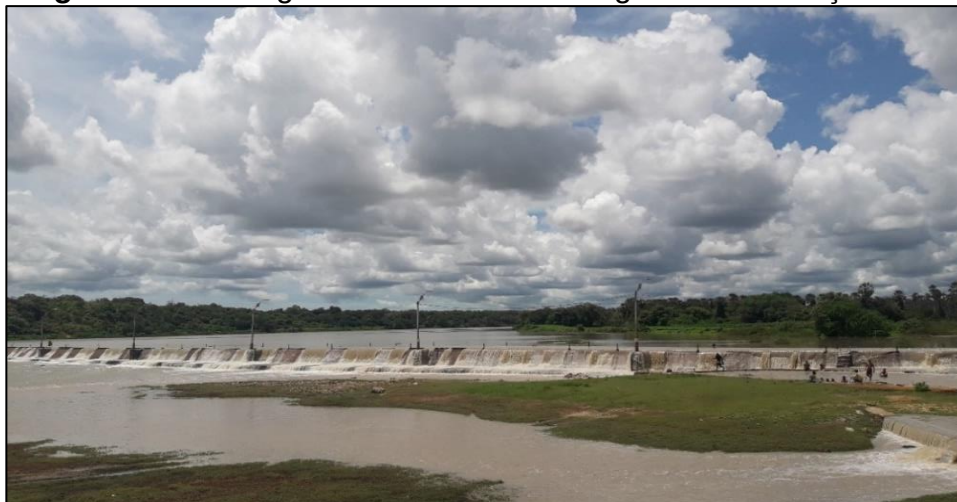
Figura 27: Passagem molhada do Rio Jaguaribe em Itaiçaba/CE
