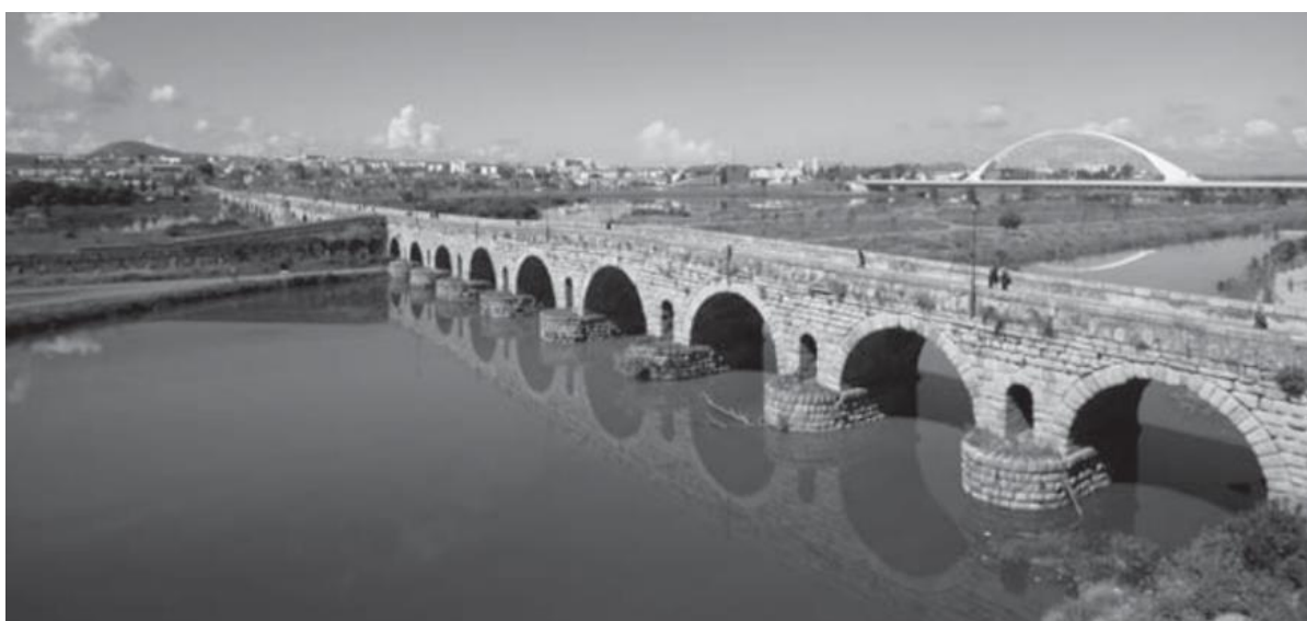
Figura 8 - Ponte atual sobre o rio Guadiana
