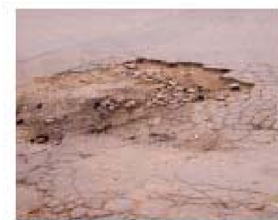
Figura 1.2. Formação de panela.
