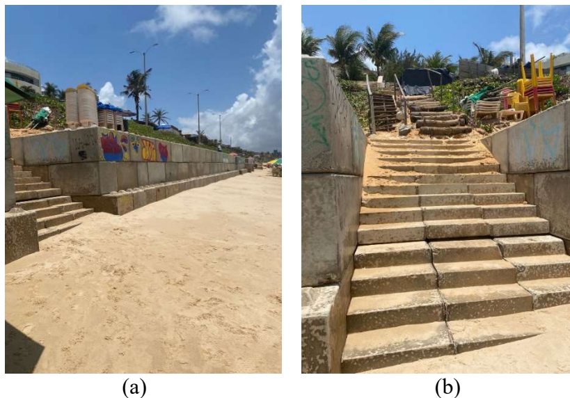
Figura 56: Estrutura de contenção rígida vertical (a) perfil (b) escadaria com deslocamento vertical
