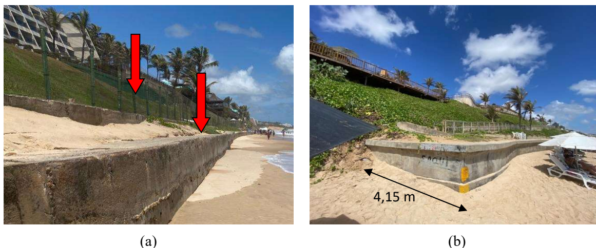
Figura 64: Hotel Ocean Palace e com duas obras de contenção adjacentes executadas em tempos diferentes
