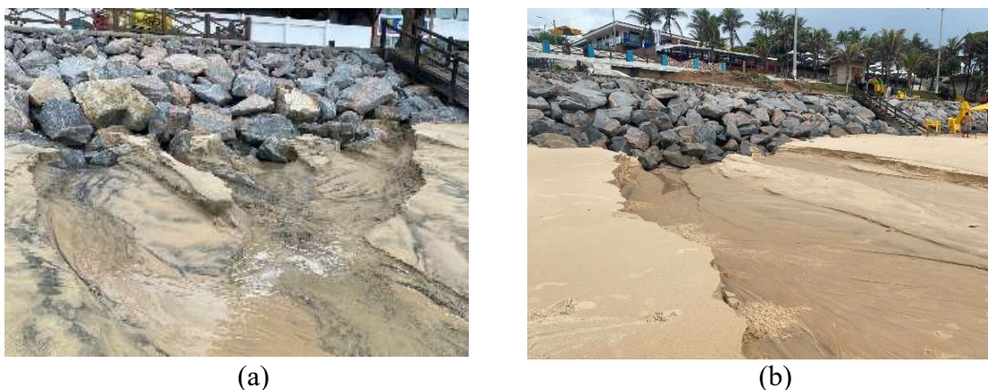
Figura 50: Erosão praial causada por galerias de água de drenagem (a) início do Setor II (b) final do Setor II
