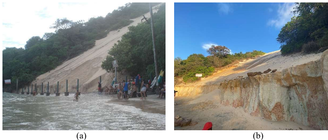
Figura 44: Vista do Morro do Careca destacando a redução do volume de sedimentos devido ao processo erosivo (a) em 2012 e (b) em 2022
