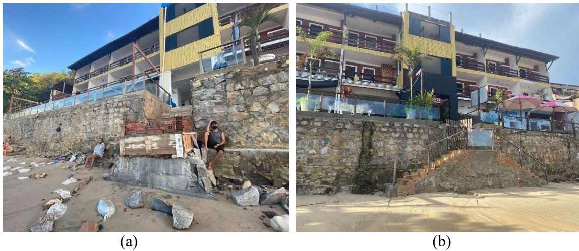
Figura 46: Edificação adaptando acesso a praia perdido devido ao rebaixamento do perfil praiial/impacto da erosão (a) antes (b) depois.
