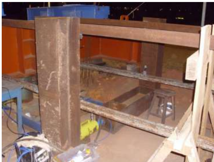
Figura 3.25 – Montagem de uma prova de carga com carregamento horizontal em estacas metálicas.
