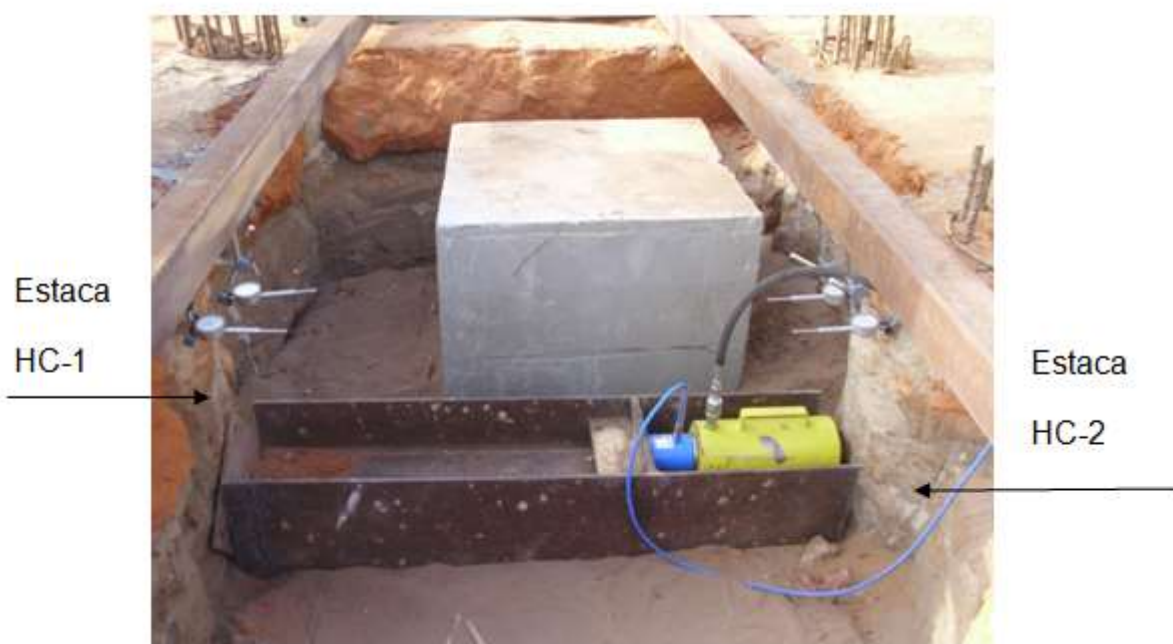
Figura 3.22 – Montagem de uma prova de carga estática com carregamento horizontal em estaca hélice contínua.
