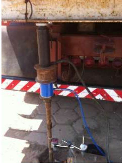
Figura 3.6 – Montagem de uma prova de carga estática no amostrador SPT (Costa et al., 2012).
