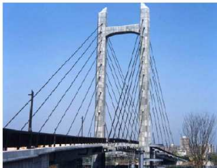
FIGURA 2.11 – Ponte Shin-kiba Ohashi executada no Japão em CAA (OKAMURA e OUCHI, 2003).
