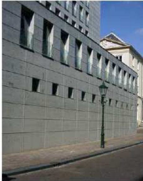
FIGURA 2.10 – Fachada em CAA do Teatro Nacional no Hague (WALRAVEN, 2005 apud TUTIKIAN, 2007).
