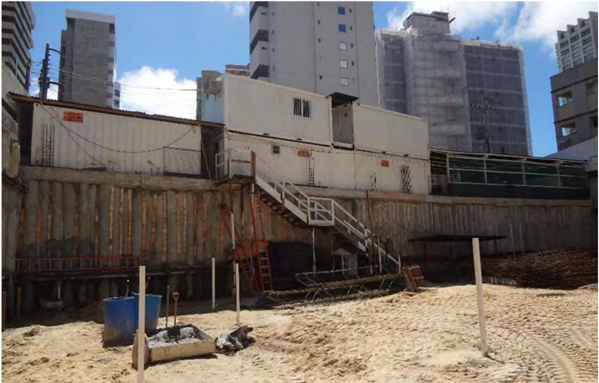
Figura 79 – Vista geral do canteiro de obras ocupando o recuo frontal da futura edificação
