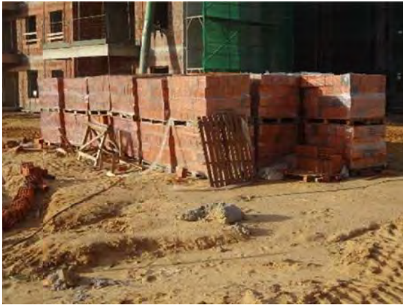
Figura 113 – Blocos cerâmicos sob pallets próximos ao bloco de apartamentos
