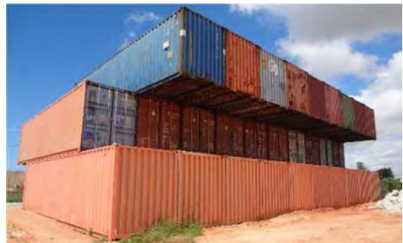
Figura 172 – Sobreposição alternada de containers com a formação de balanço com 2,50m
