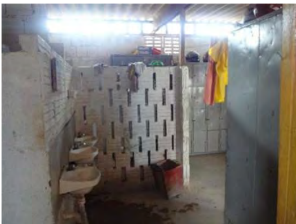
Figura 29 – Setor 01 - vista interna dos banheiros/vestiários dos funcionários
