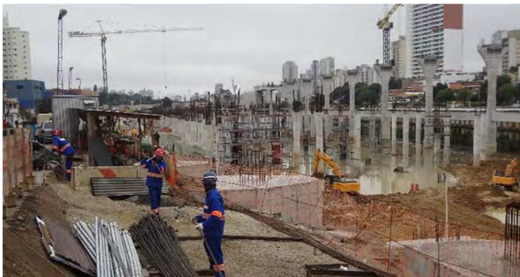
Figura 119 – Vista geral do pátio da obra da Linha Ouro do Monotrilho da cidade de São Paulo/SP
