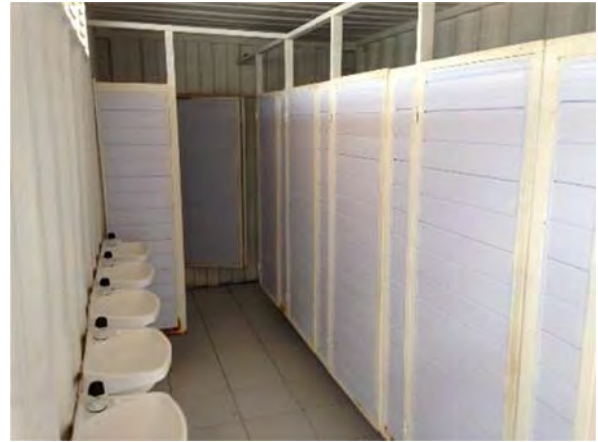
Figura 50 – Adaptação pronta com pias e boxes para os vasos sanitários
