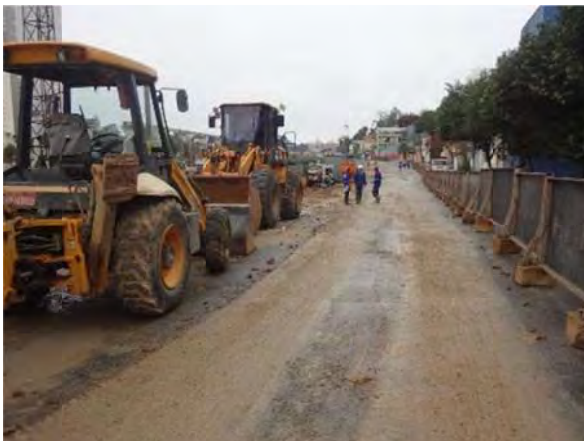
Figura 123 – Via parcialmente interditada, separando o fluxo da obra e dos moradores
