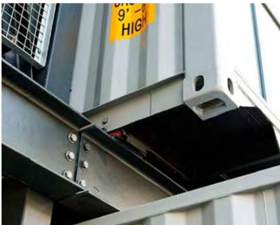
Figura 147 – Dispositivos de canto existentes em todas as extremidades do container
