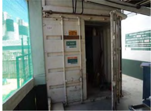
Figura 81 – Container sem adaptação que funciona como almoxarifado
