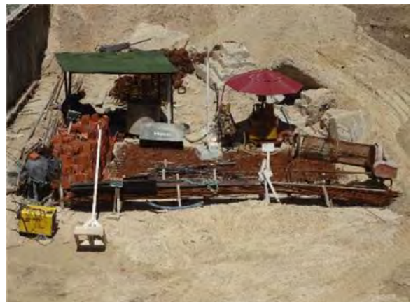
Figura 85 – Central de armação feito com pilaretes de madeira e guarda sol
