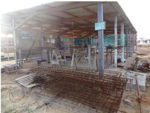
Figura 109 – Central de armação com bancada de trabalho e serra policorte
