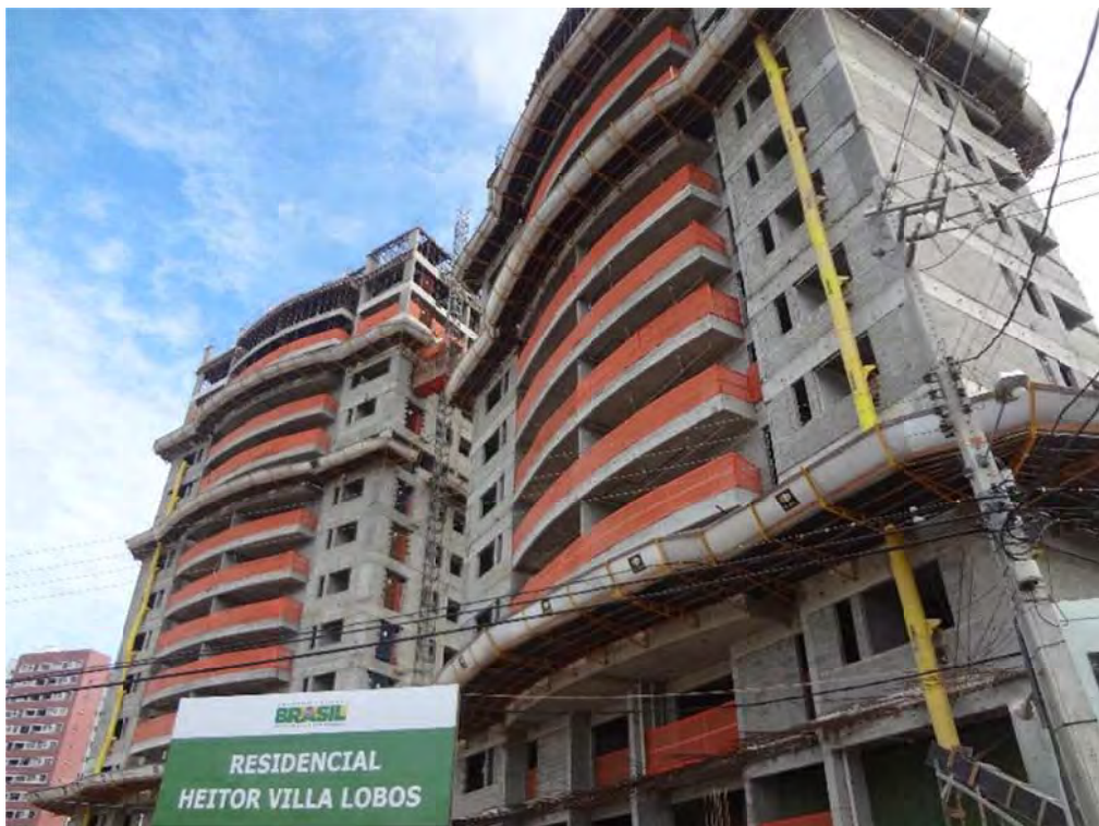
Figura 18 – Vista geral das torres em construção
