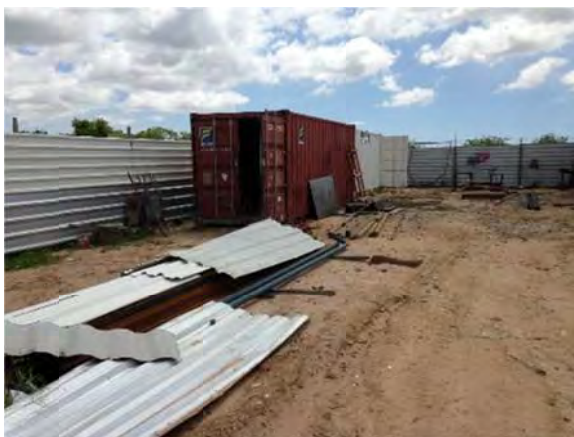
Figura 63 – Container usado como depósito sem nenhuma adaptação. Ambiente quente e escuro
