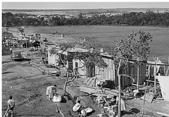
Figura 5 – Edificações do canteiro de obras de Brasília/DF. Em 1959, eram 64 mil trabalhadores
