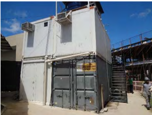
Figura 90 – Containers adaptados para escritórios e outro sem adaptação para almoxarifado
