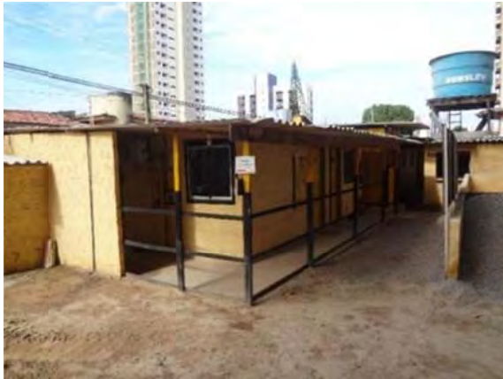
Figura 27 – Vista do setor 01, administrativo, com a sala de recursos humanos e baias de britas
