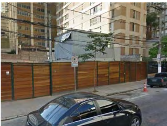
Figura 139 – Containers empilhados na área do recuo frontal da futura edificação
