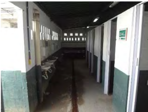
Figura 68 – Banheiros em alvenaria com cobertura de telha ecológica
