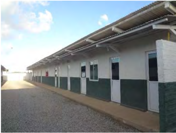
Figura 103 – Pavilhão construído para abrigar o setor administrativo
