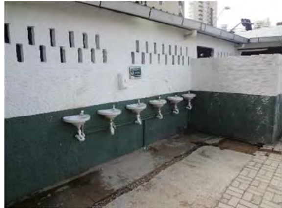
Figura 67 – Setor de vivência. Pias localizadas no acesso aos banheiros e vestiários
