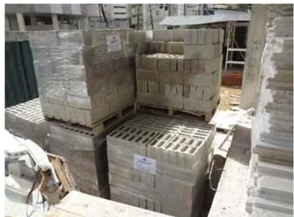
Figura 71 – Blocos de cimento utilizados nas alvenarias comprados em pallets
