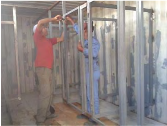
Figura 49 – Colocação de divisórias internas para separar os vasos sanitários
