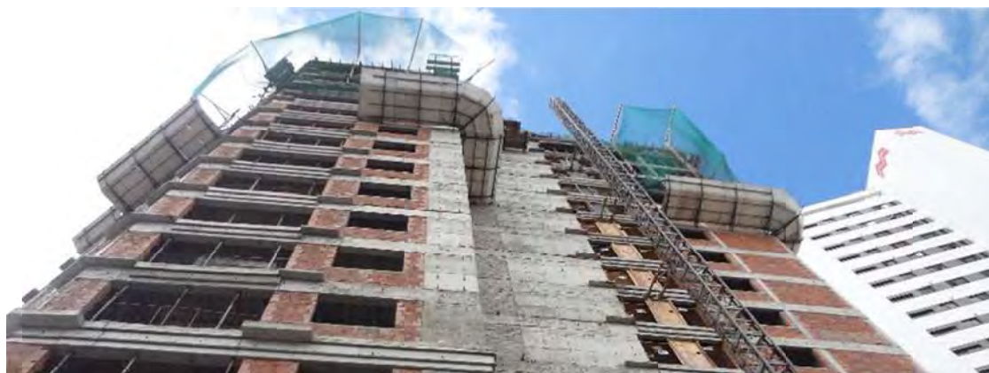
Figura 65 – Vista geral da edificação em construção
