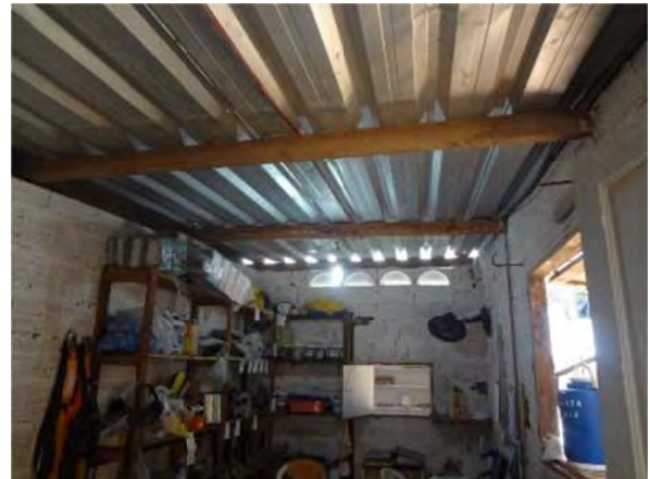
Figura 35 – Almoxarifado sem ventilação cruzada. Ventilador instalado na parede
