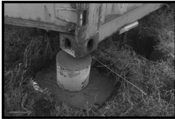
Figura 197 – Exemplo do apoio da extremidade do container
