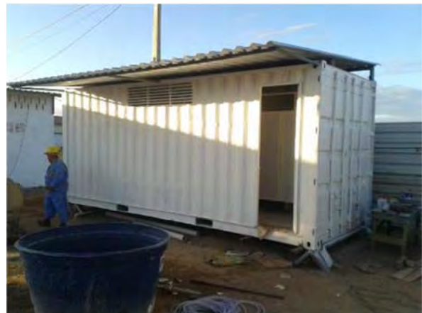
Figura 48 – Container adaptado para abrigar os banheiros com a única janela existente
