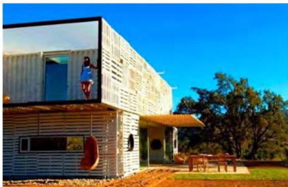
Figura 169 – Vista exterior da Infiniski House . A proteção lateral se eleva e forma uma marquise
