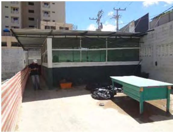
Figura 98 – Refeitório para 160 funcionários com telha de alumínio e vão telado nas laterais
