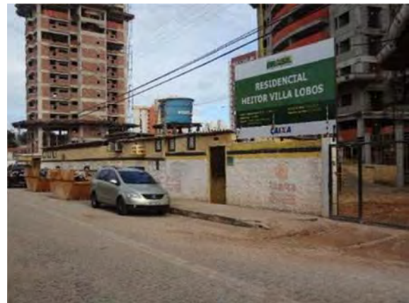
Figura 26 – Vista geral externa do canteiro de obras, mostrando o acesso de pedestres e de material
