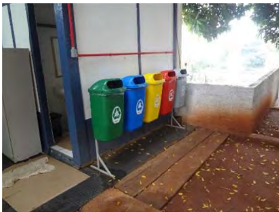
Figura 127 – Lixeiras de coleta seletiva espalhadas pela obra para gestão dos resíduos
