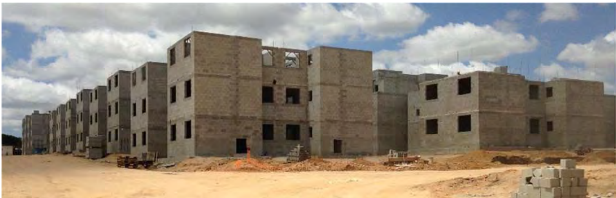
Figura 44 – Vista geral dos blocos em construção
