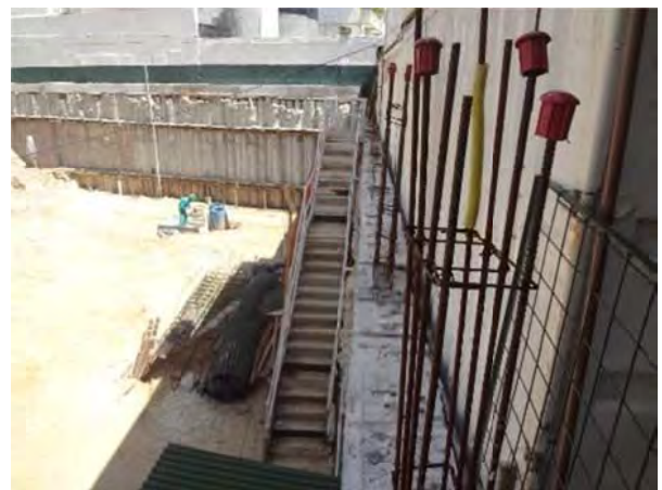
Figura 87 – Muro de contenção e escada de acesso ao nível do segundo subsolo
