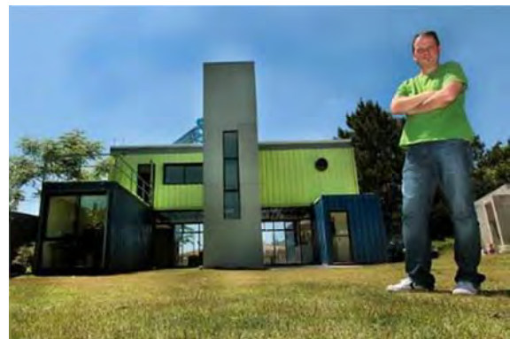
Figura 156 – Fachada posterior da Casa-container de Danilo Corbas
