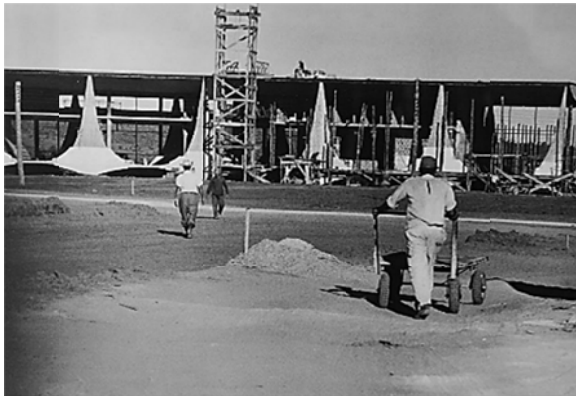
Figura 3 – Construção do Palácio da Alvorada. Em 1957, eram 2,5 mil trabalhadores
