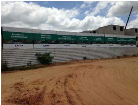
Figura 42 – Placas de obra anunciando os oito condomínios residenciais
