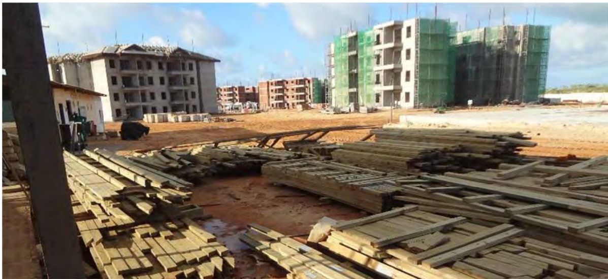
Figura 102 – Vista geral das edificações sendo construídas
