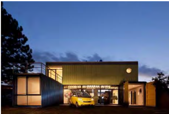
Figura 153 – Fachada frontal da Casa-container de Danilo Corbas
