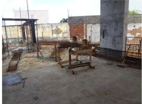
Figura 74 – Central de armação com serra policorte no térreo, sob a torre em construção
