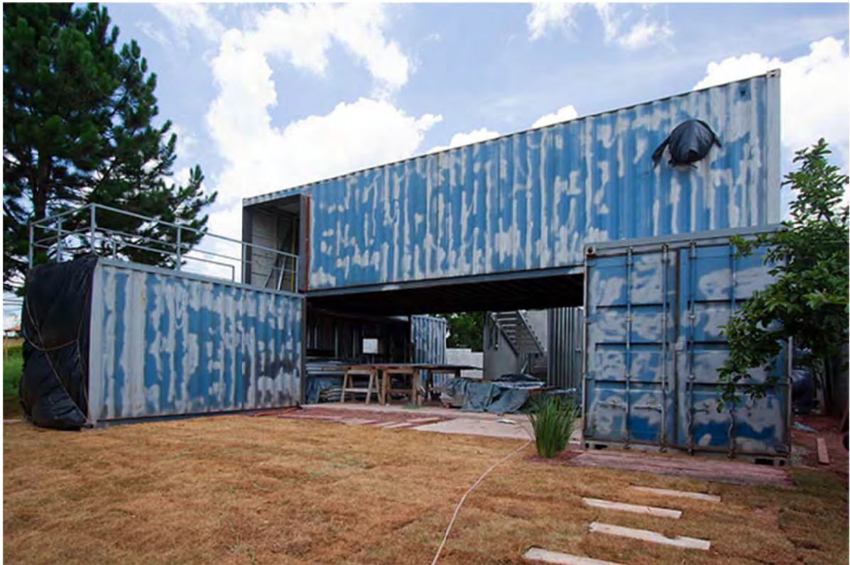
Figura 152 – Imagem da casa em construção. Containers sem pintura, recém colocados no local
