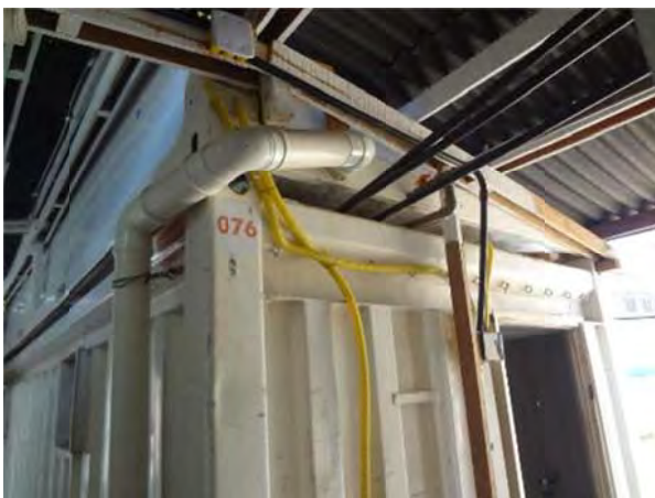
Figura 86 – Containers empilhados apresentando as instalações hidrosanitárias e elétricas
