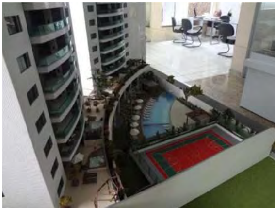
Figura 25 – Maquete mostrando a área de lazer fora da projeção das lajes, local do canteiro de obras
