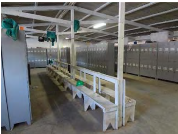
Figura 107 – Amplo vestiário, com armários e bancos, construído em alvenaria
