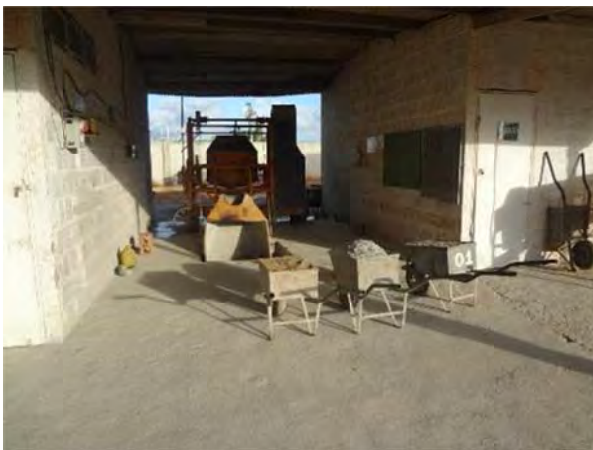
Figura 111 – Central de argamassa com betoneira, baias de areia, brita e depósito de cimento e cal
