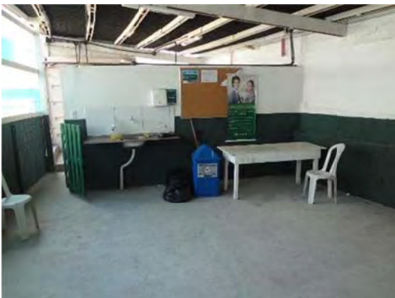
Figura 84 – Cobertura do refeitório em telhas ecológicas de cor escura. Presença de ventiladores
