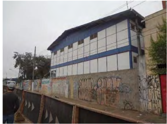
Figura 126 – Edificação próxima a obra que contém o setor administrativo e de vivência
