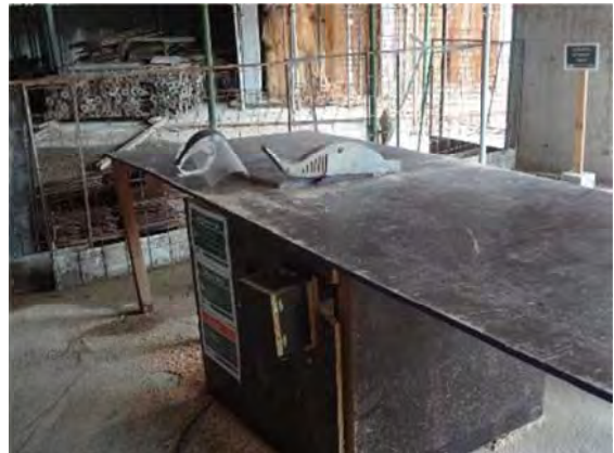
Figura 76 – Central de fôrmas localizada no pavimento térreo da obra em construção
