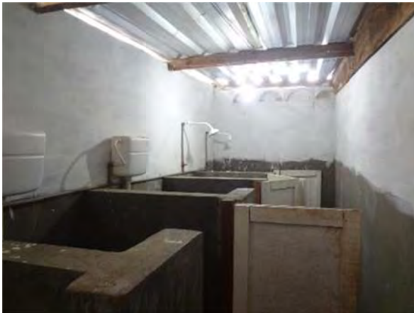
Figura 34 – Banheiro dos funcionários. Abertura para ventilação e iluminação feita por cobogós
