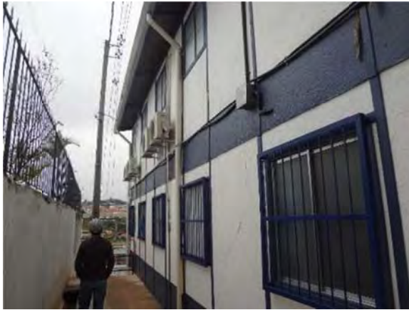
Figura 125 – Edificação do canteiro com dois pavimentos formada por alvenaria e madeira
