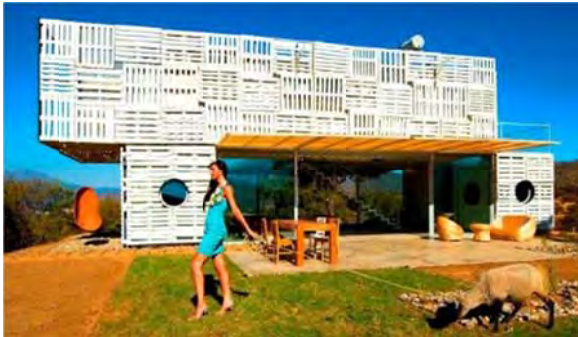
Figura 167 – Vista exterior da Infiniski House com fachada revestida por pallets
