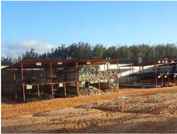
Figura 117 – Almojarifado de tubos com fácil acesso de caminhões para descarga
