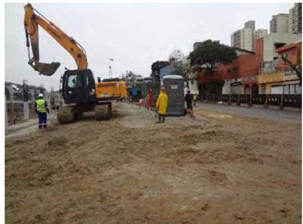
Figura 124 – Máquinas pesadas em operação próximas a residências – barulho intenso
