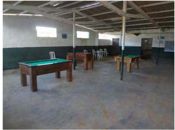
Figura 118 – Área de convivência dos funcionários. Esta edificação será demolida ao final da obra
