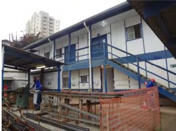
Figura 129 – Vista lateral da edificação que abriga o setor administrativo e de vivência
