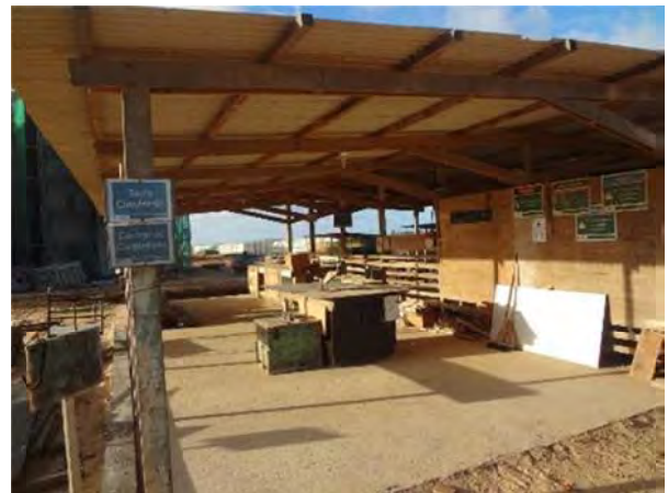
Figura 110 – Central de fôrmas com bancada de trabalho e serra policorte
