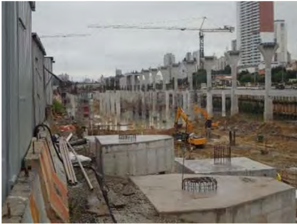
Figura 121 – Mega construção - visão geral dos pilares que suportarão o caminho do Monotrilho
