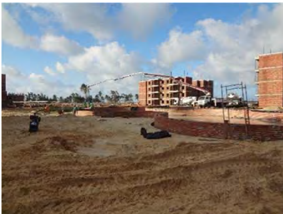
Figura 115 – Caminhão lança e betoneira na concretagem da piscina. Espaço para manobras
