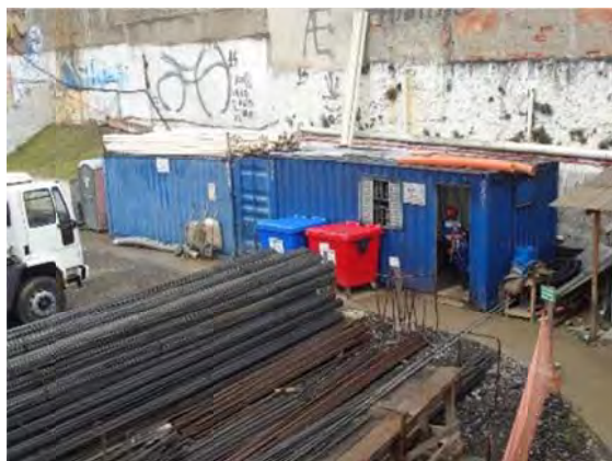
Figura 137 – Depósito de ferramentas formado por containers com pouca adaptação para o novo uso
