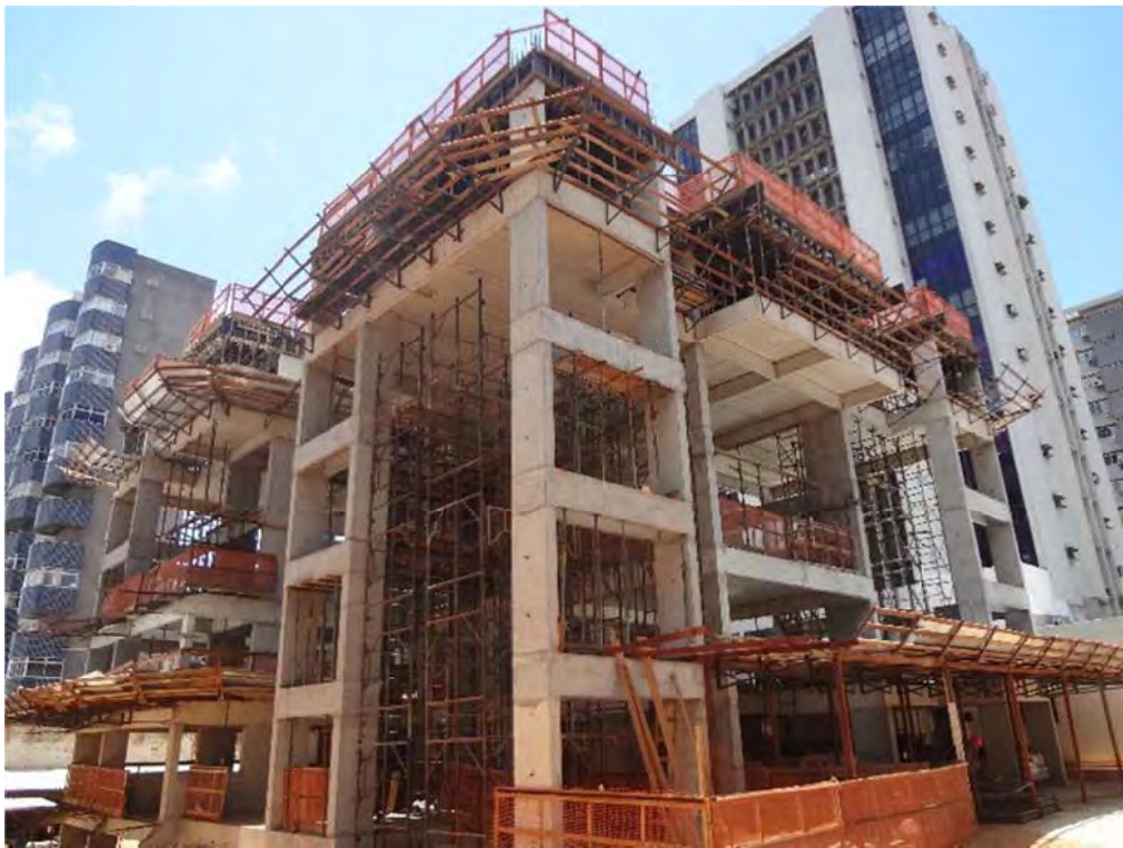
Figura 31 – Vista geral da torre em construção
