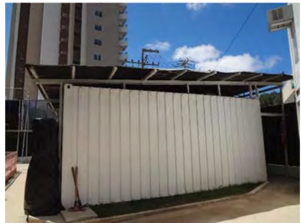
Figura 95 – Telhado sobre o container
