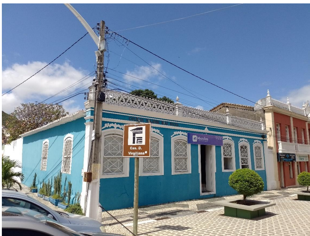
Figura 34. Casa da Praça Castro Alves, nº 61.
