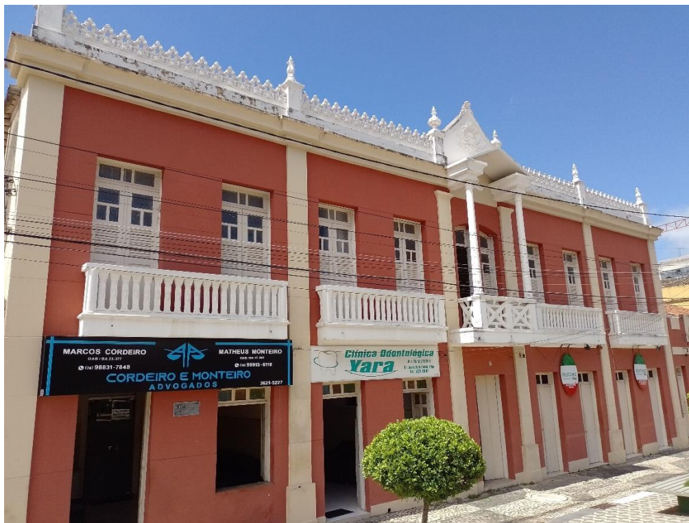
Figura 37. Casarão localizado na Praça Castro Alves.
