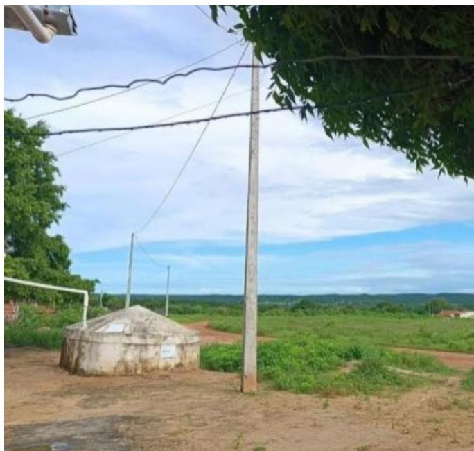
Figura 18 - Cisterna de 16 mil litros de água construída pela ASA por meio do Programa 1 Milhão de Cisternas
