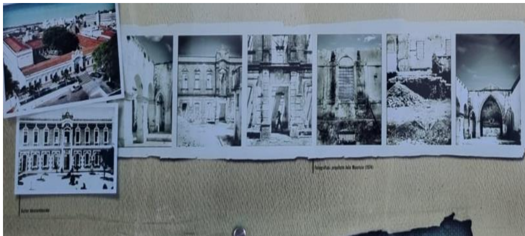
Figura 2 – Imagens da arquitetura da Casa de Detenção de Petrópolis
