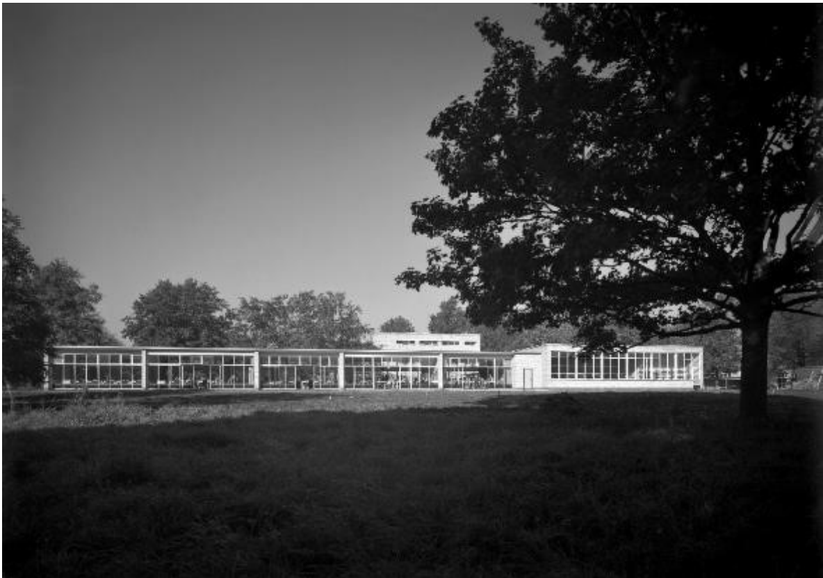
Figura 29: Vista do bloco de salas de aula da Escola Impington, onde se percebe a transparência das salas de aula, e na extremidade o laboratório.
