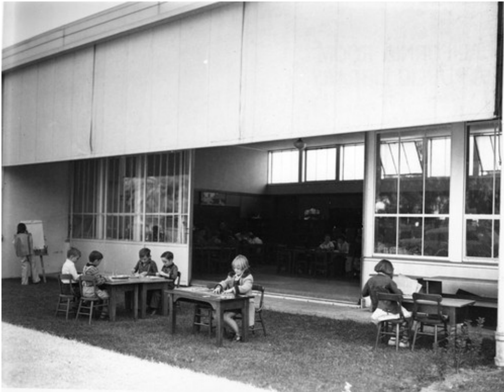
Figura 28: Alunos na Escola Corona, realizando atividades na sombra ao ar livre, em mobiliário levado do interior da sala de aula. Percebe-se ainda o toldo para proteção solar e as janelas na outra face da sala de aula que facilitam a ventilação cruzada.
