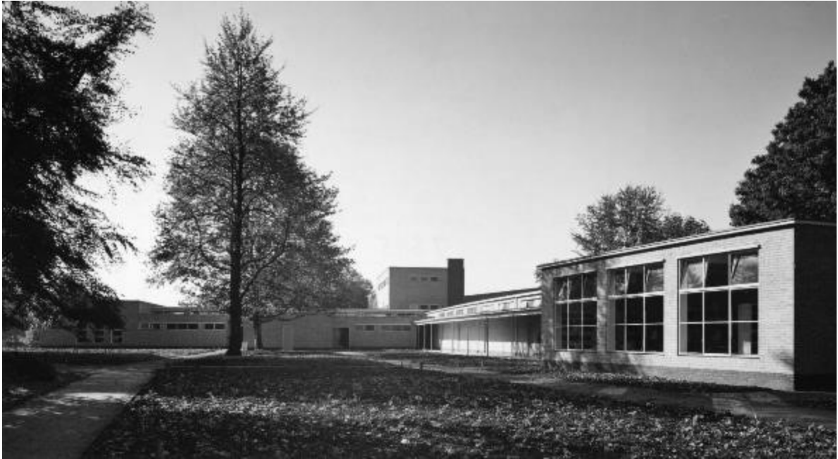
Figura 33: Escola Impington: edifício com suas alas envoltas aos jardins.
