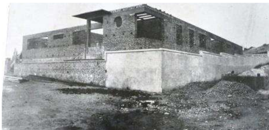
Figura 59: Grupo escolar de Picuí (4 salas de aula), seguindo o novo modelo, ainda construção em 1938
