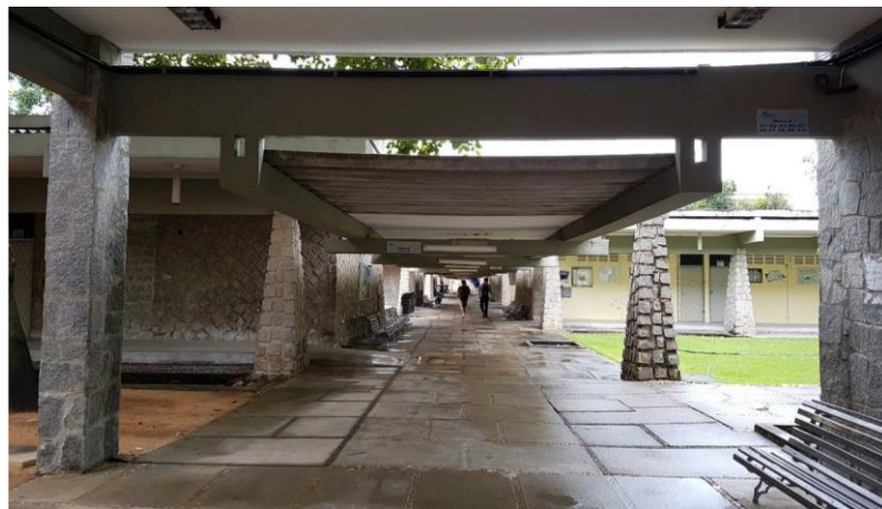
Figura 14 - Circulação central que interliga os blocos do setor de aulas teóricas IV da UFRN.
