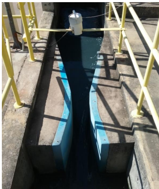
Figura 6 – Calha Parshall da ETE Capuava.
