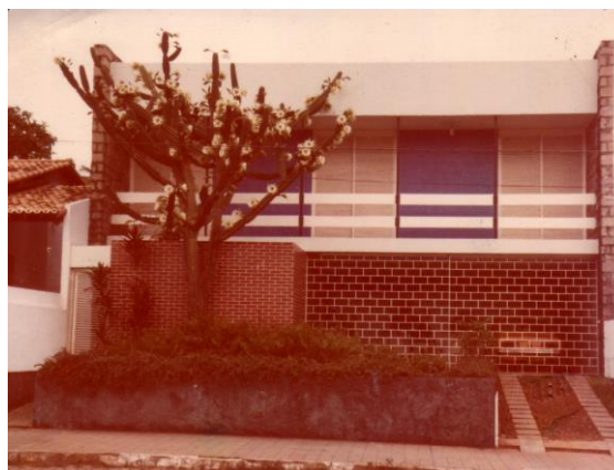
Casa de Jaeci Galvão que foi construída no início da década de 1960, na Rua Afonso Pena, Bairro do Tirol em Natal. Arquetetada pelo amigo João Maurício Miranda. Acervo Jaeci Júnior.
