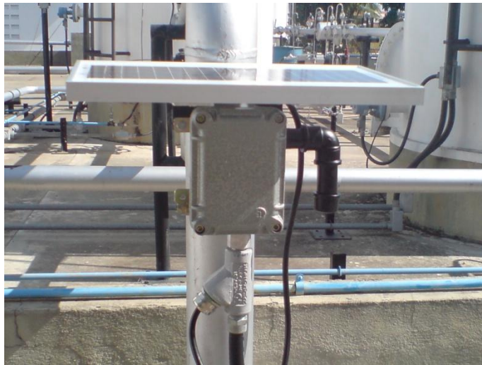
Figura 4.15. Montagem de cada sistema embarcado.
