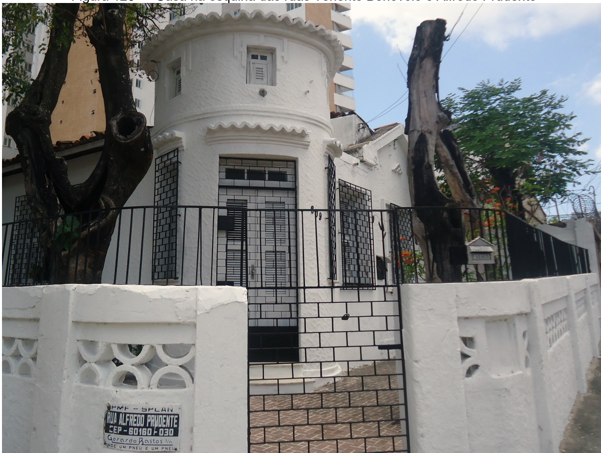
Figura 126 — Casa na esquina das ruas Tenente Benévolo e Alfredo Prudente
