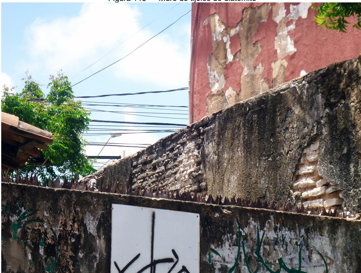
Figura 118 — Muro de tijolos de diatomito
