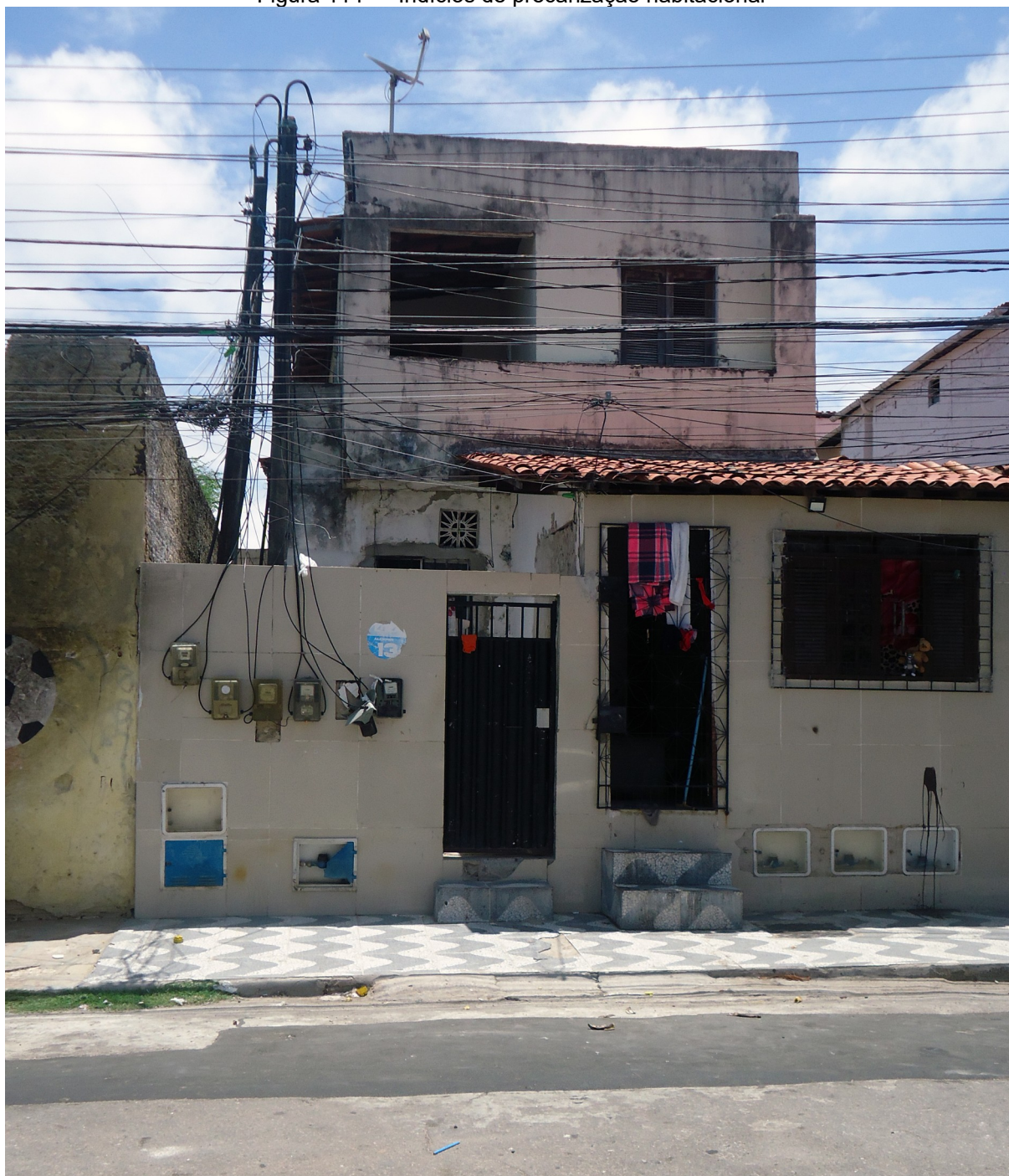
Figura 114 — Indícios de precarização habitacional
