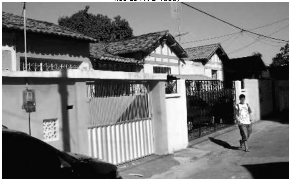
Figura 86 — Casas na antiga Vila Ferroviária do Otávio Bonfim (CAP dos Ferroviários da RVC-1938)
