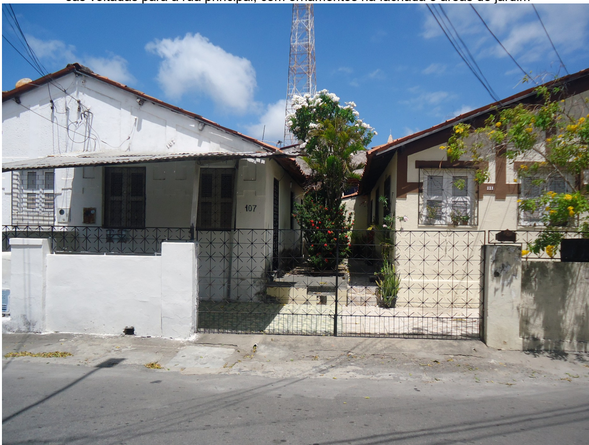
Figura 61 — Exterior da vila construída em terreno de propriedade de Júlio Siqueira, na Piedade: casas voltadas para a rua principal, com ornamentos na fachada e áreas de jardim
