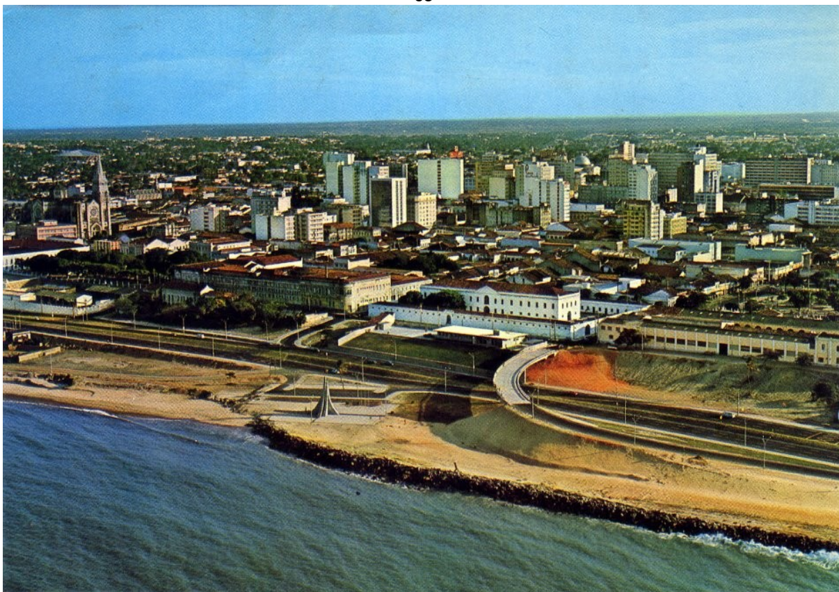
Figura 108 — Remoção do Arraial Moura Brasil com a abertura da Avenida Presidente Castelo Branco
