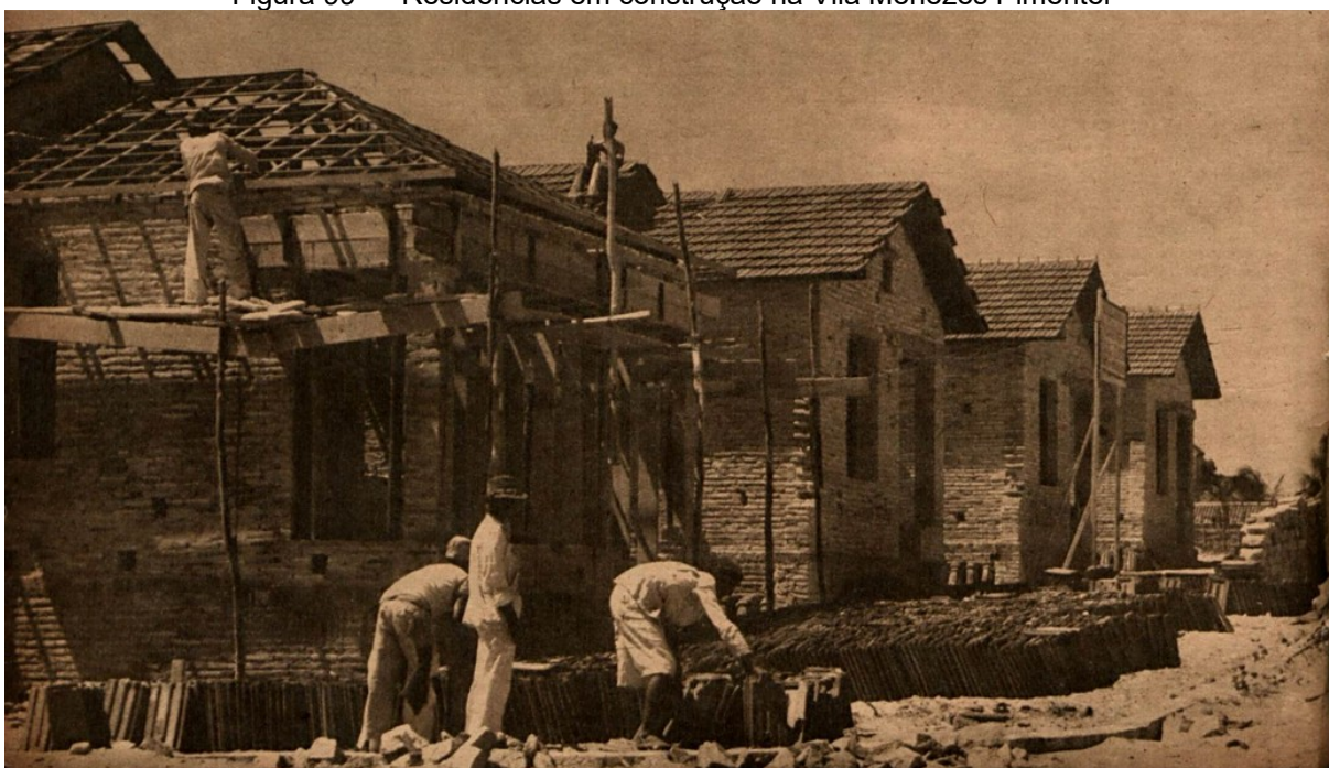
Figura 99 — Residências em construção na Vila Menezes Pimentel
