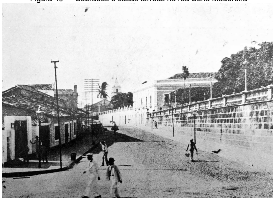
Figura 40 — Sobrados e casas térreas na rua Sena Madureira
