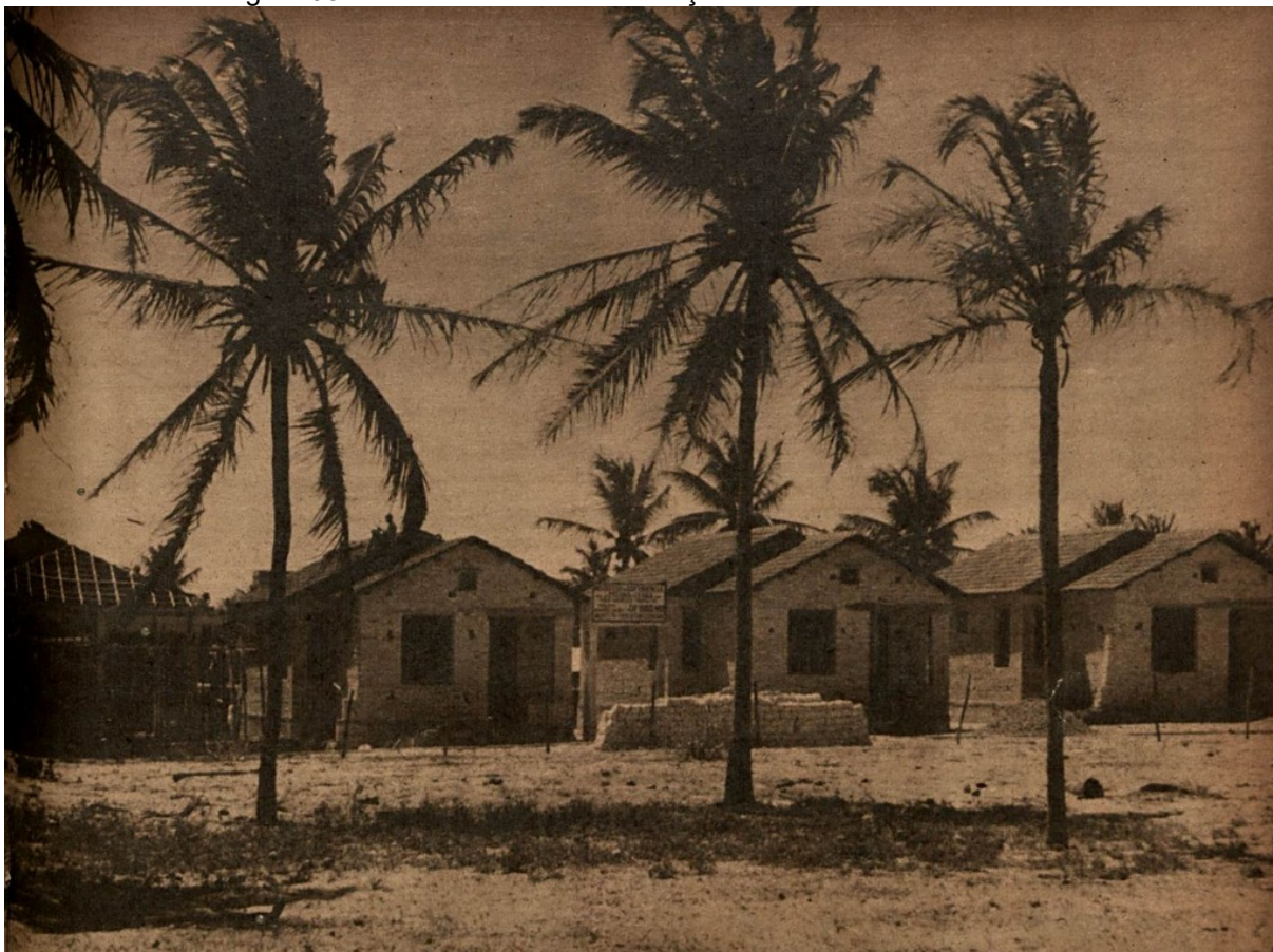
Figura 98 — Residências em construção na Vila Menezes Pimentel
