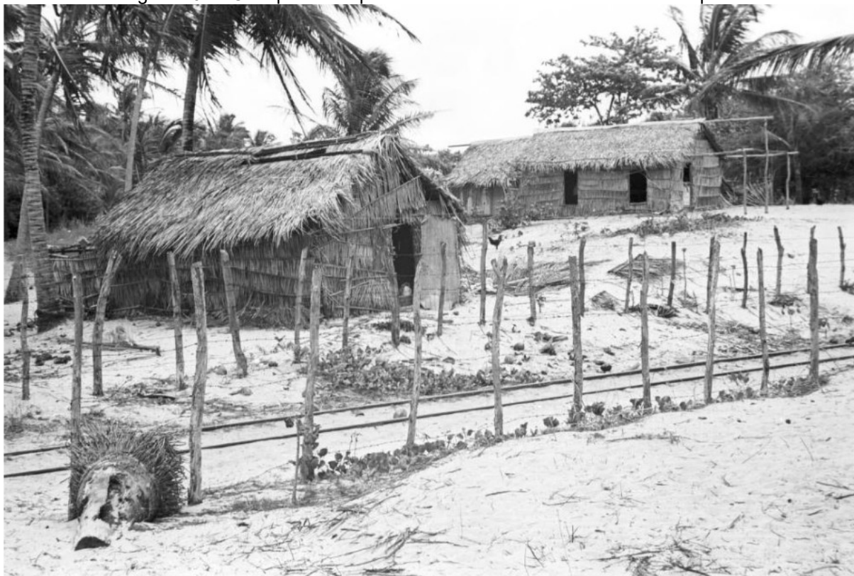
Figura 26 — Choupanas de palha situadas entre o trilho e a faixa de praia
