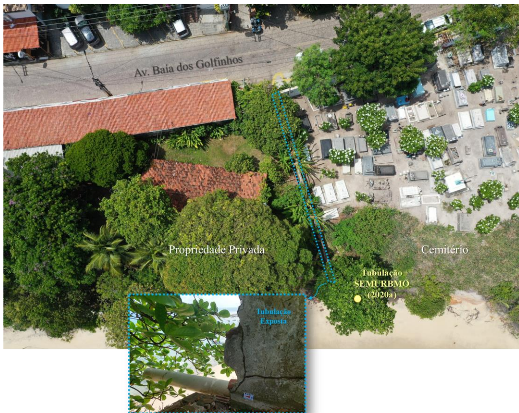
Figura 39: Imagem de drone da área de estudo com destaque para a tubulação exposta, em azul. A posição real do alvo está a 5 metros, aproximadamente, do ponto apresentado no relatório da SEMURBMO (2020a), em amarelo. Fonte: Autora (2022).
