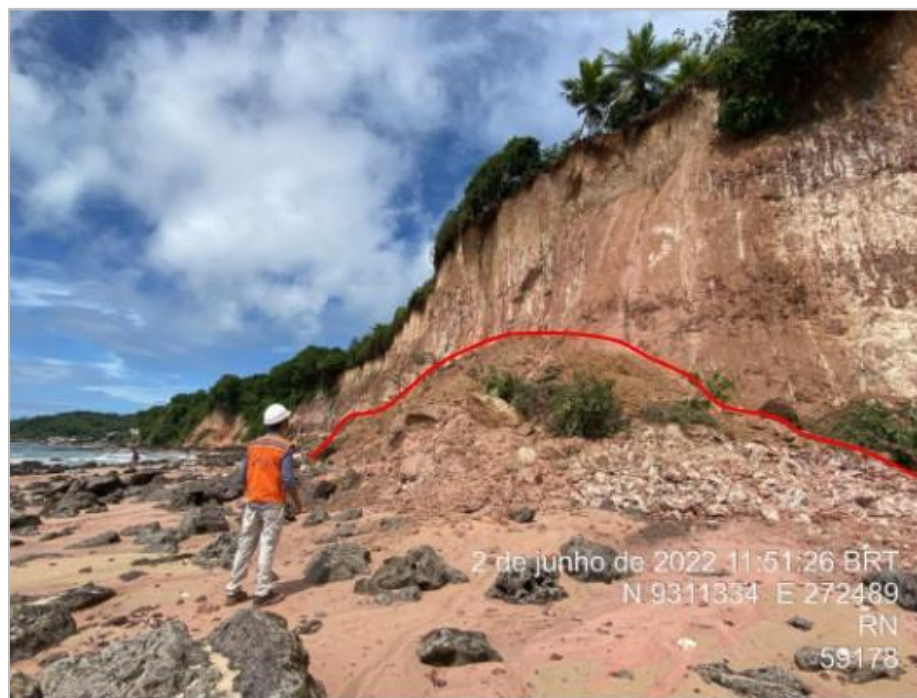
Figura 8: Deslizamento de massa ocasionado por chuva intensa em junho/2022, destacado em vermelho. Fonte: Silva & Marinho Filho (2022).
