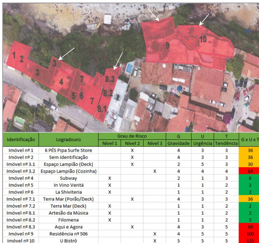
Figura 19: Vistoria de 10 imóveis na área de risco da Praia de Pipa, dentre os quais, quatro apresentam risco crítico e iminência de deslizamentos, destacados pelas setas em branco.
