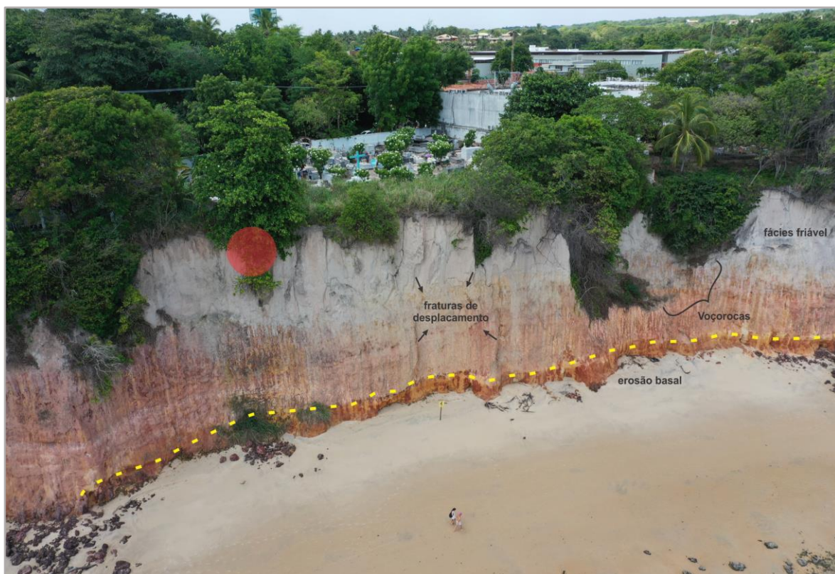
Figura 32: Feições erosivas encontradas na área de estudo: fraturas de deslocamento, erosão basal (linha pontilhada amarela), formação de voçorocas nas cicatrizes de colapso vegetadas, e a porção com fácies mais friável; elas encontram-se bastante próximas do do local onde está a tubulação exposta (círculo vermelho).
