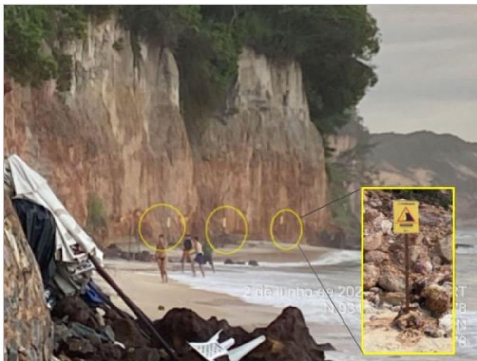
Figura 9: Demonstração da maré alta alcançando as sinalizações, promovendo desgaste e danos, sendo necessárias constantes vistorias para verificar sua conservação.
