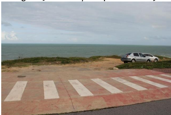
Figura 85 - Demarcação no piso do acesso 9.
