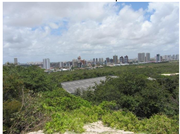
Figura 66 - Coberta do Centro de Convenções, ao fundo área de tabuleiro do Parque das Dunas.
