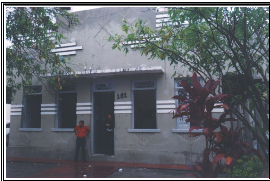
Figura 04 – Primeiro prédio que sediou o Seminário de Aracaju, em 1913.
