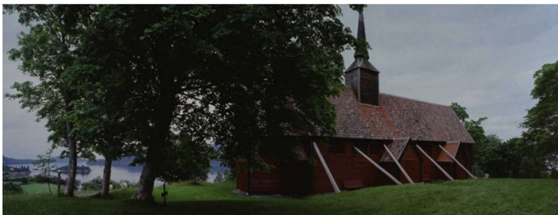
Figura 24: Stave church do tipo Møre de Kvernes com os postes externos.
