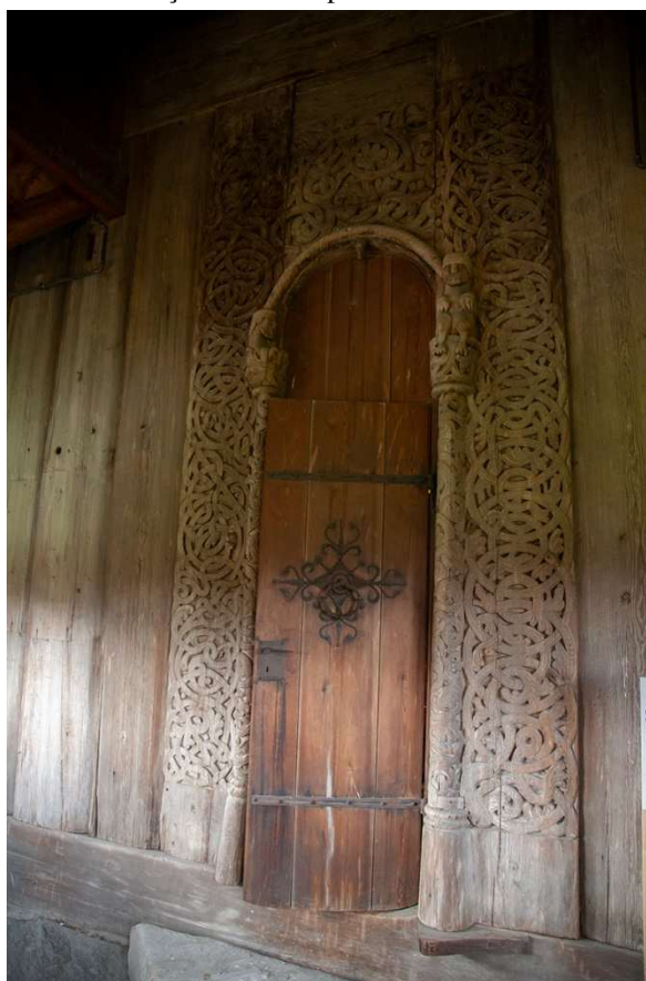
Figura 47: Presença de anel na porta da stave church de Heddal.
