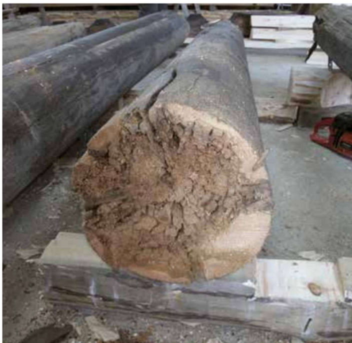
Figura 15: Pilar retirado do campanário da igreja de Borgund como elucidação da dimensão dos troncos usados para sustentação das estruturas.
