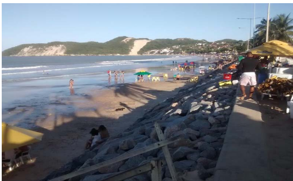
Figura 1. Enrocamento do calçadão e equipamentos de acesso à faixa de areia da Praia de Ponta Negra/RN
